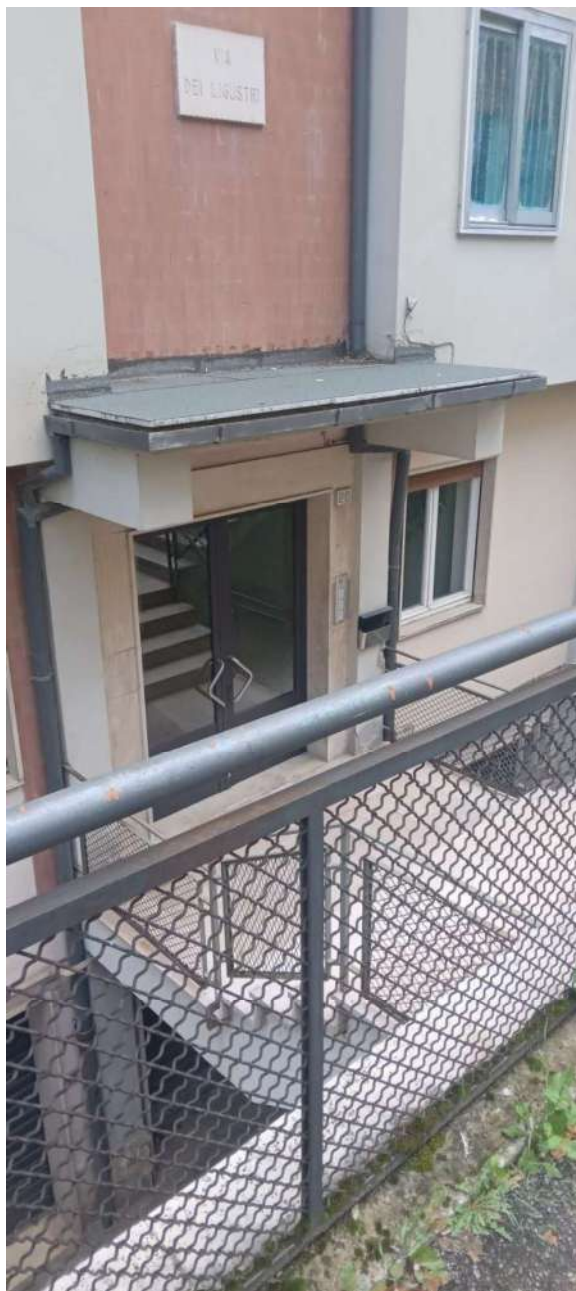
Ingresso al fabbricato sul prospetto Ovest
