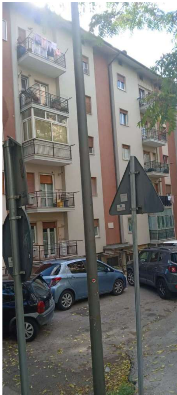
Facciata Ovest del fabbricato
