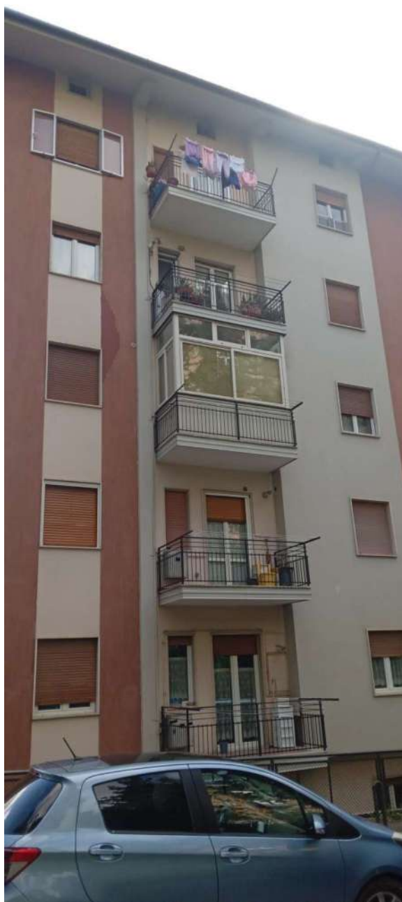
Facciata Ovest del fabbricato
