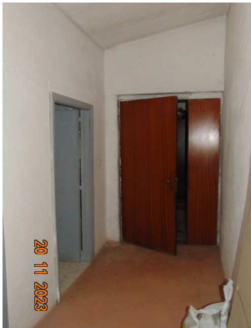
Ingresso da corridoio cond. - (Cantina)
