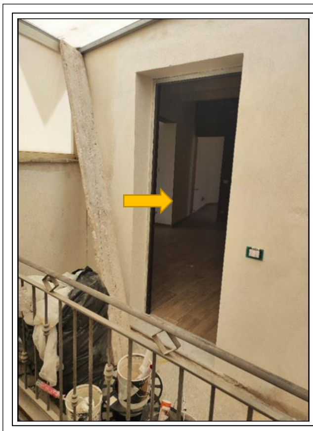
Foto N°7 - Part. accesso all'unità immobiliare di Piano III , a sx.
