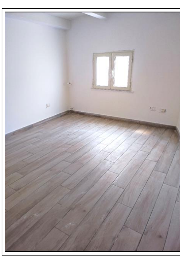
Foto N°20 - Camera da Letto 3 : particolare serramento prospiciente la corte
