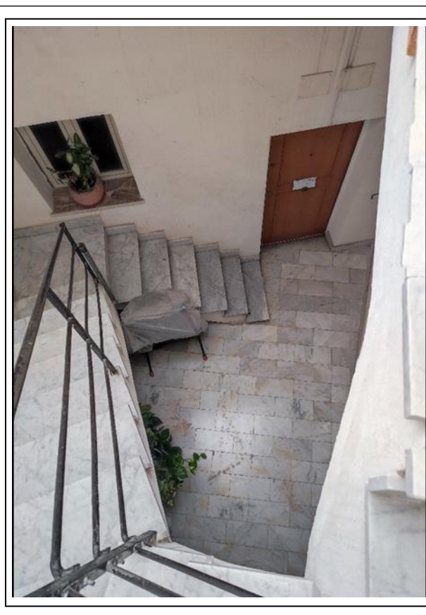
Foto N°6 - Rampa di accesso al Piano III con chiostroina
