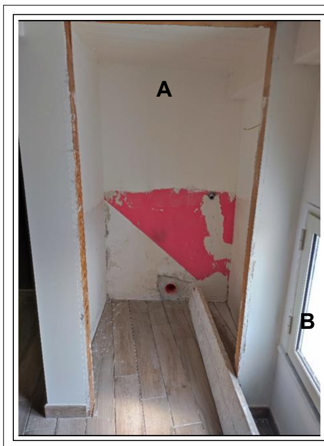
Foto N°19 - Camera da Letto 2: (A) W.C.; (B) serramento prospiciente la corte
