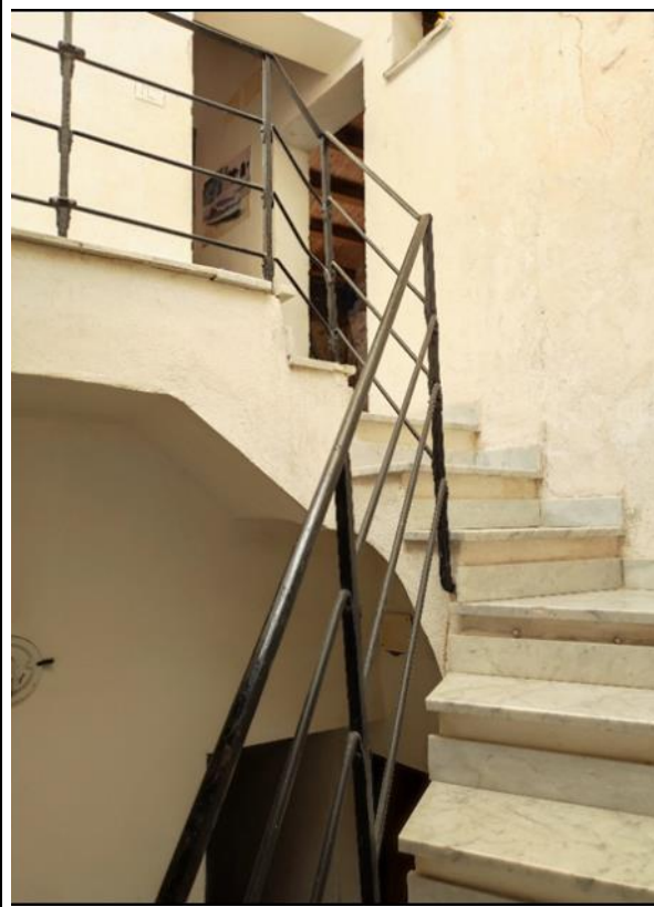
Foto N°22 - Part. scala d'accesso all'unità immobiliare
