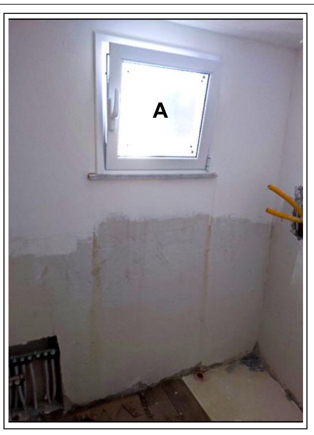
Foto N°14 - Lavanderia annessa al W.C. : (A) serramento in alluminio anodizzato preverniciato con apertura a vasistas ;
