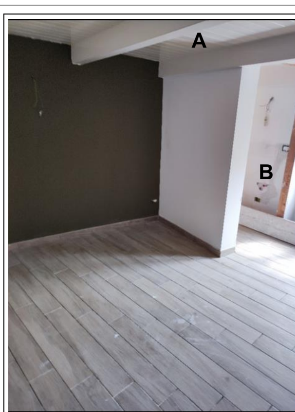
Foto N°18 - Camera da Letto 2: (A) intradosso solaio ligneo ; (B) W.C.;
