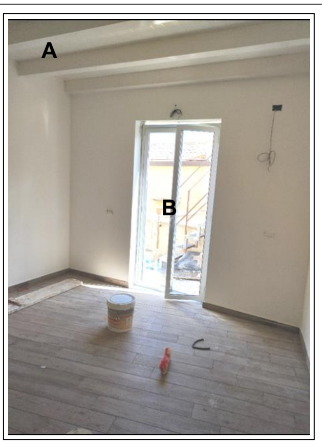
Foto N°16 - Camera da Letto 1: (A) intradosso solaio ; (B) porta-finestra su corte
