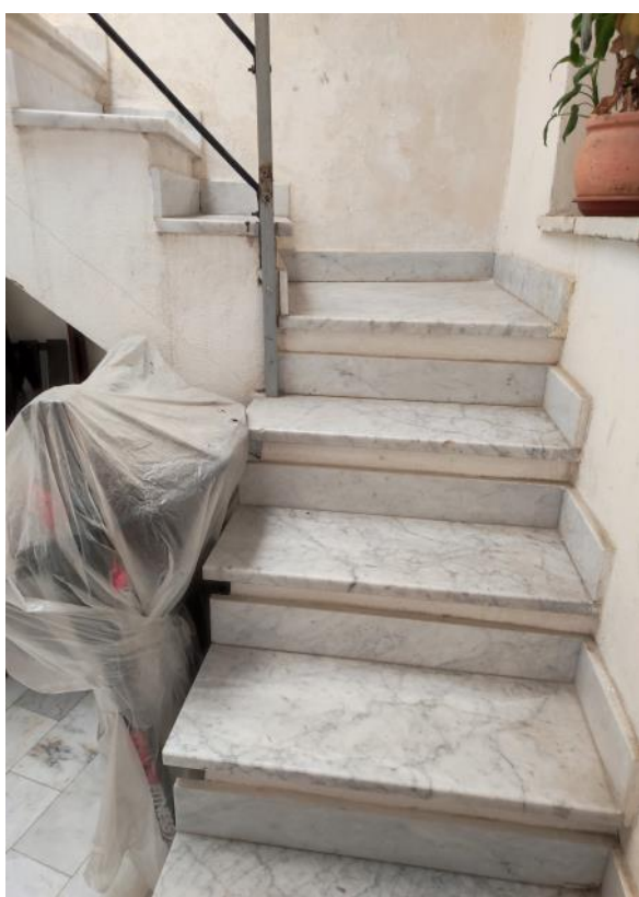
Foto N°23 - Part. gradini della scala d'accesso, rivestiti con marmo Carrara, spess.cm.3
