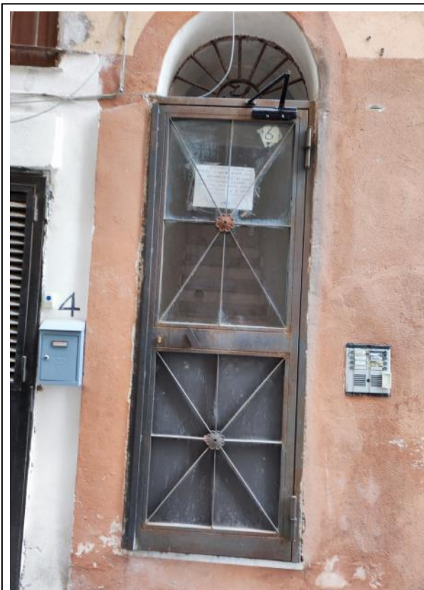
Foto N°4 - L'accesso da Vicolo Maestro Cristofaro N°6
