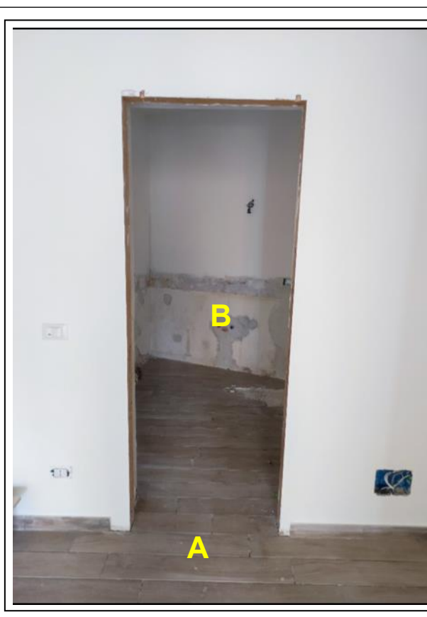
Foto N°12 - (A) Accesso al W.C. dal Pranzo - Soggiorno ; (B) W.C.
