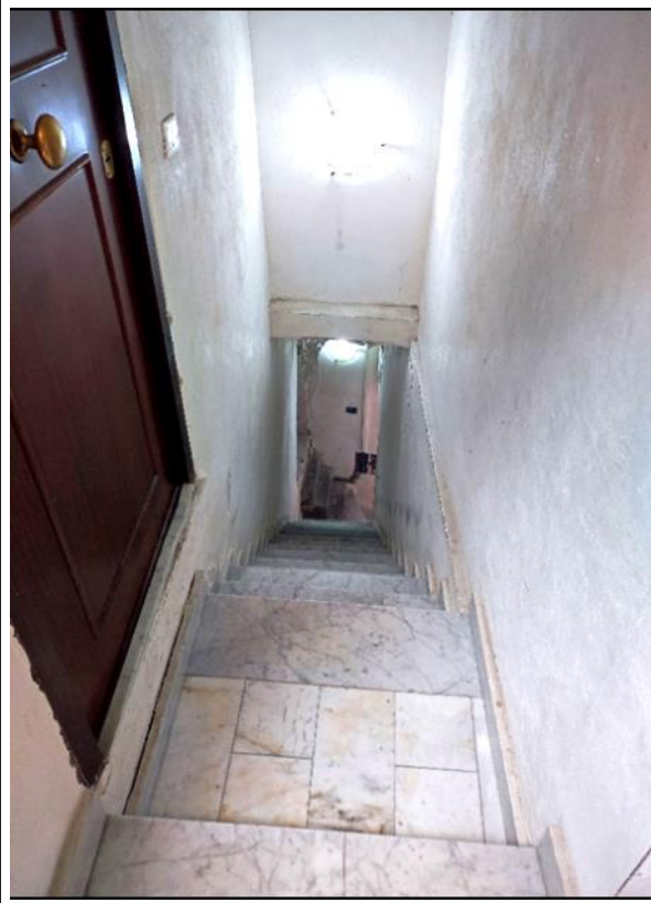
Foto N°24 - Controcampo sulla rampa principale d'accesso
