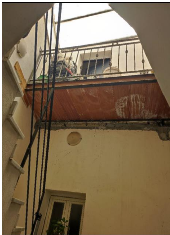
Foto N°21 - Part. ballatoio d'accesso all'unità immobiliare, ripreso dalla Chiostrina
