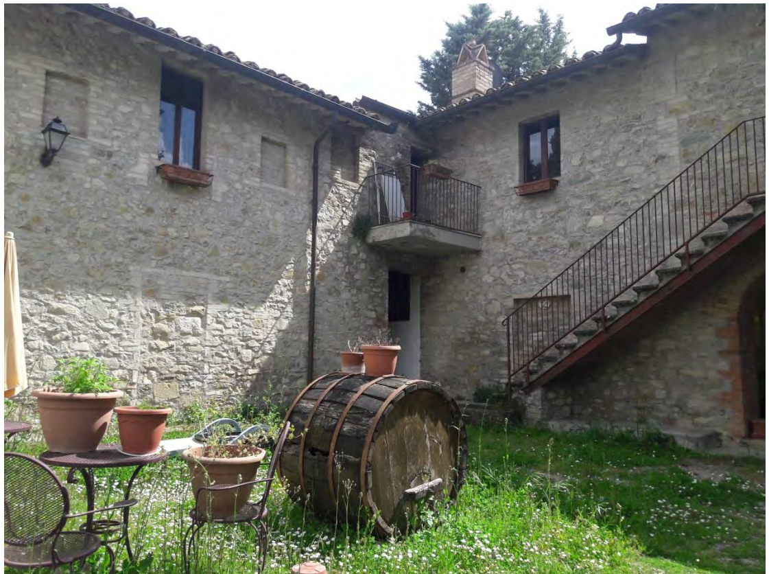
FOTO 6 (vista da nord, corte interna)
