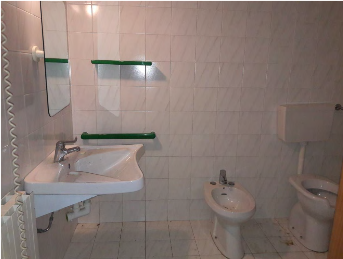
FOTO 9 (PIANO TERRA: bagno)
