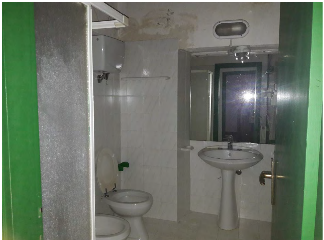
FOTO 18 (PIANO PRIMO: bagno)
