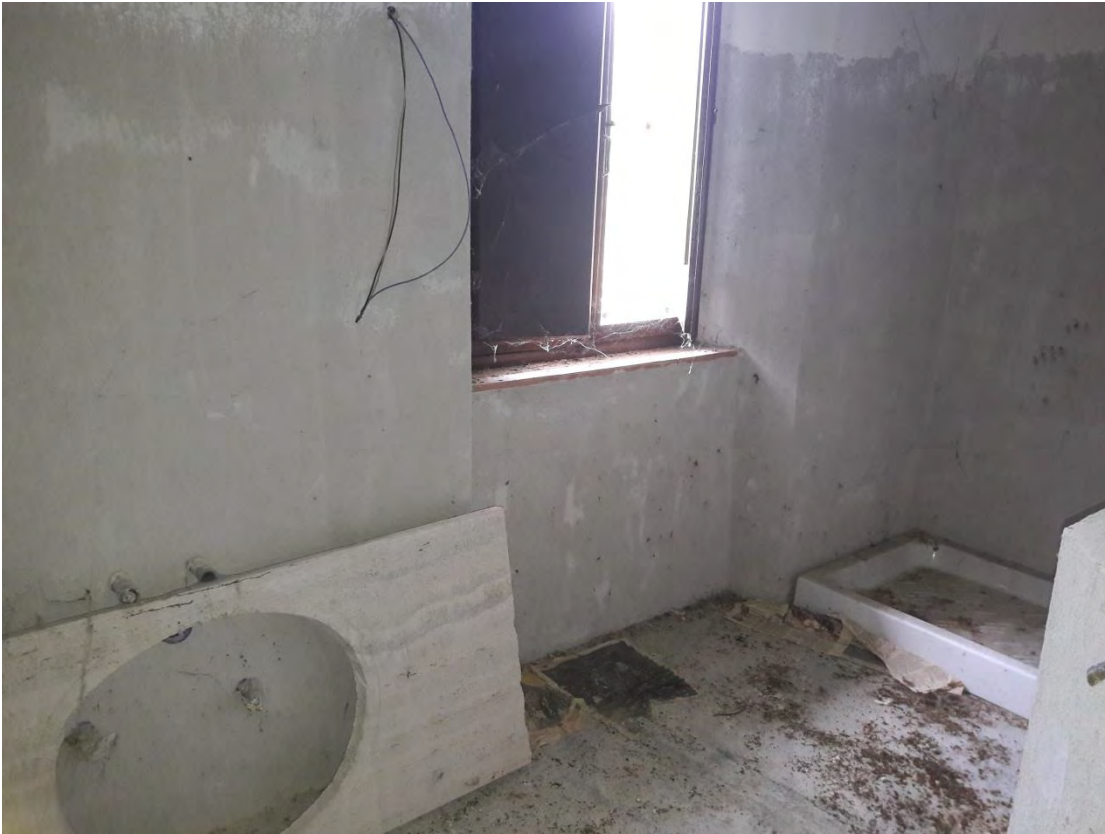
FOTO 25 (PIANO PRIMO: bagno)
