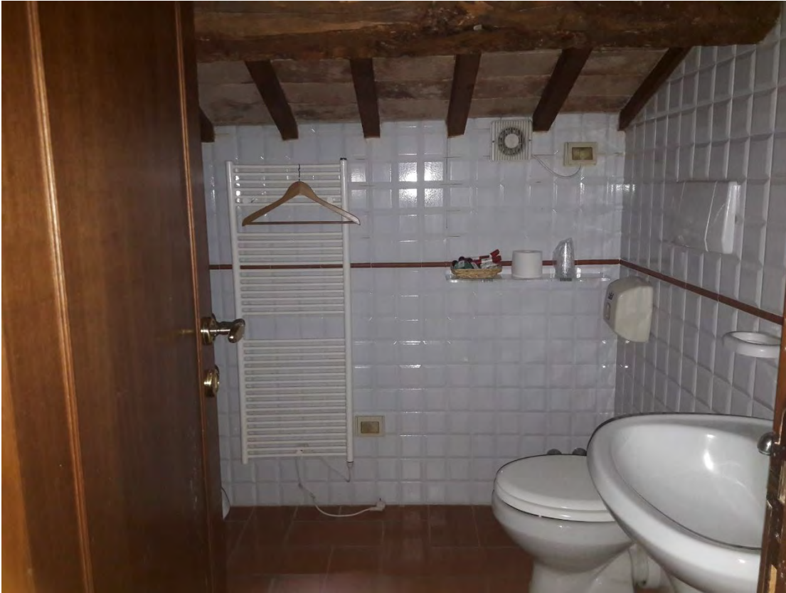
FOTO 59 (VILLA ADA: Sottotetto)
