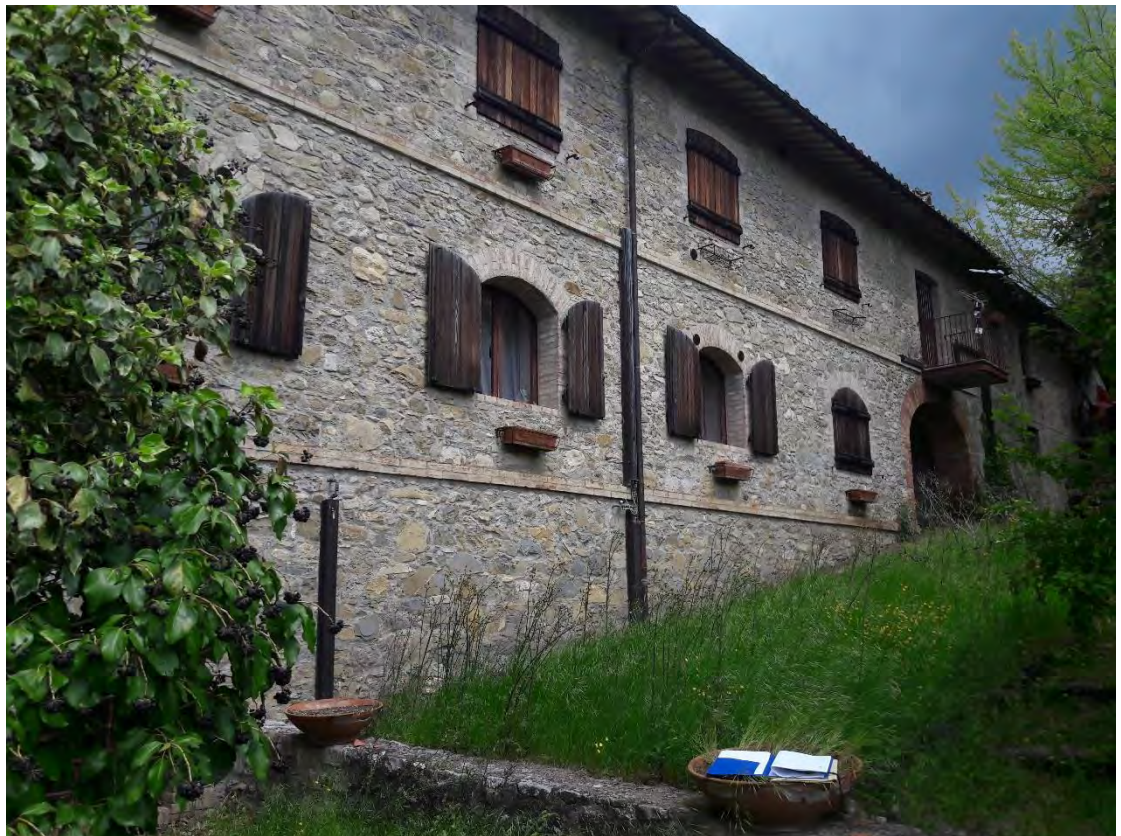
FOTO 4 (vista da sud)
