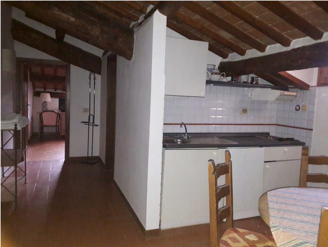
FOTO 57 (VILLA ADA: Sottotetto)
