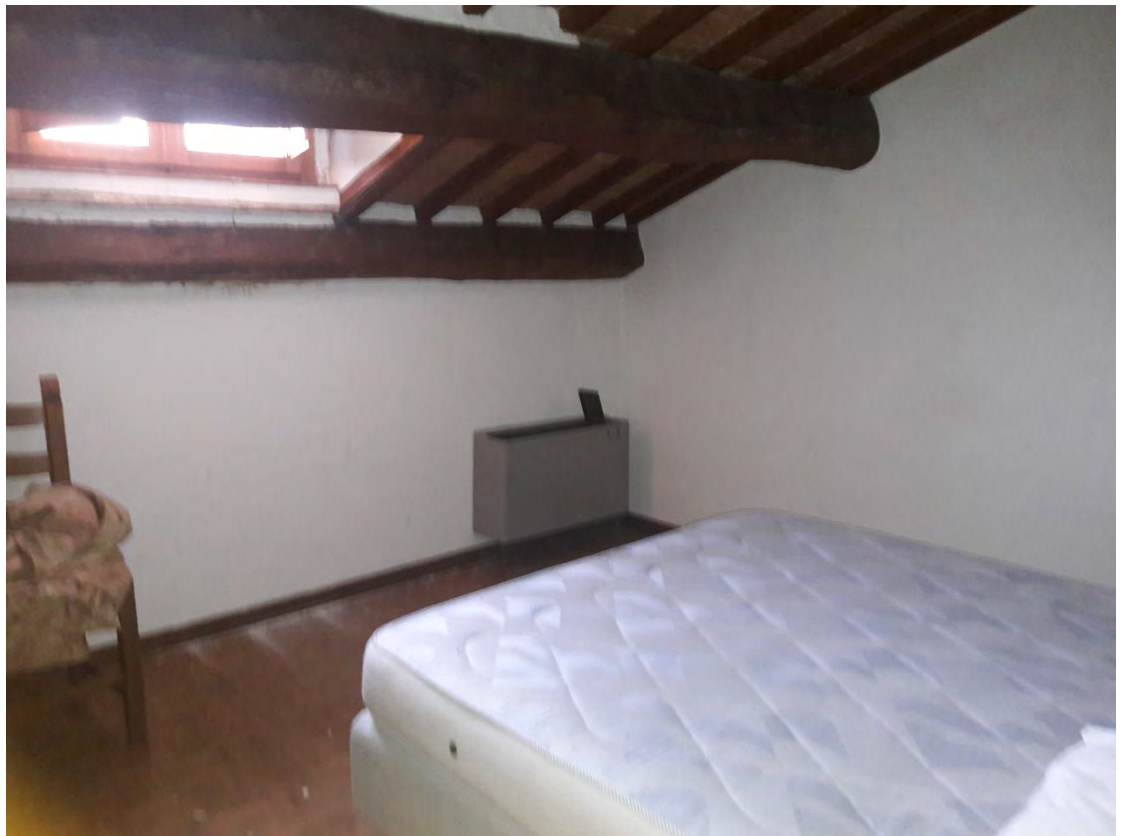
FOTO 62 (VILLA ADA: Sottotetto)
