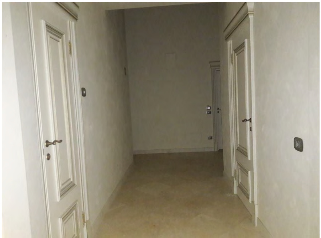
FOTO 40 (VILLA ADA: Disimpegno Piano Primo Sottostrada)
