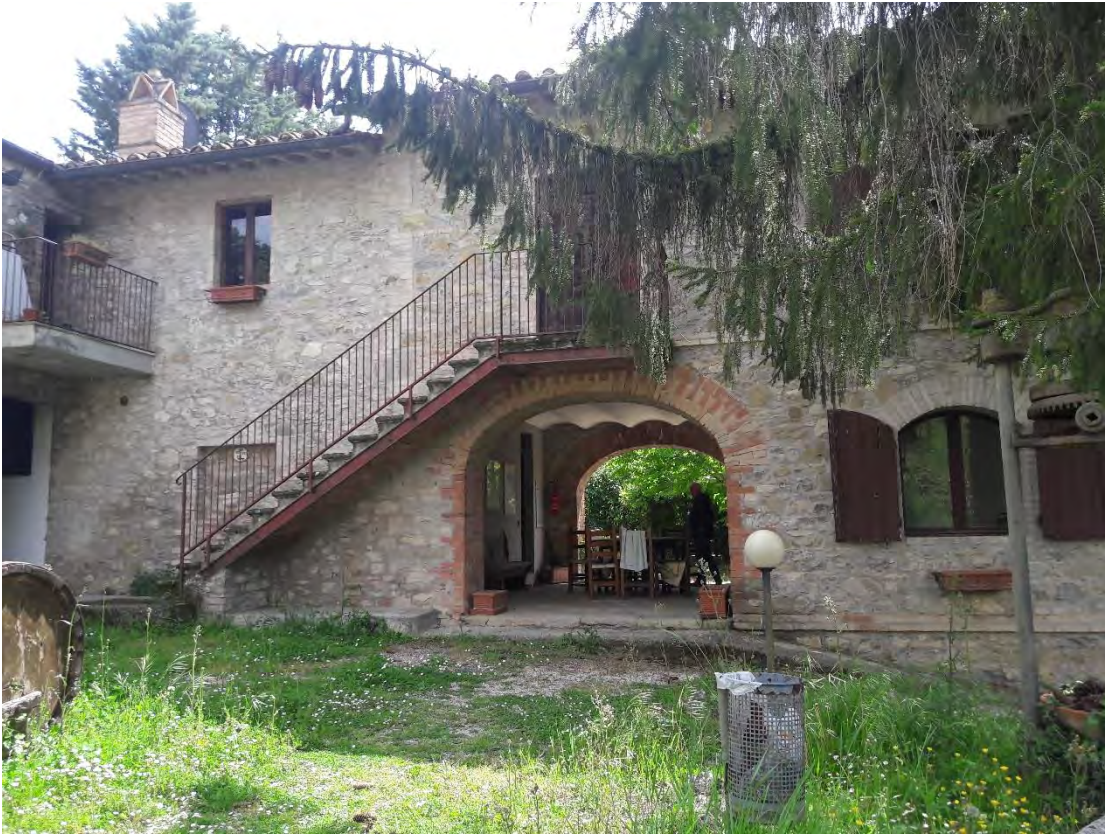
FOTO 5 (vista da nord, corte interna)
