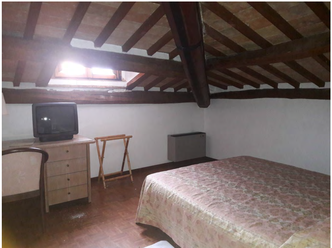
FOTO 58 (VILLA ADA: Sottotetto)
