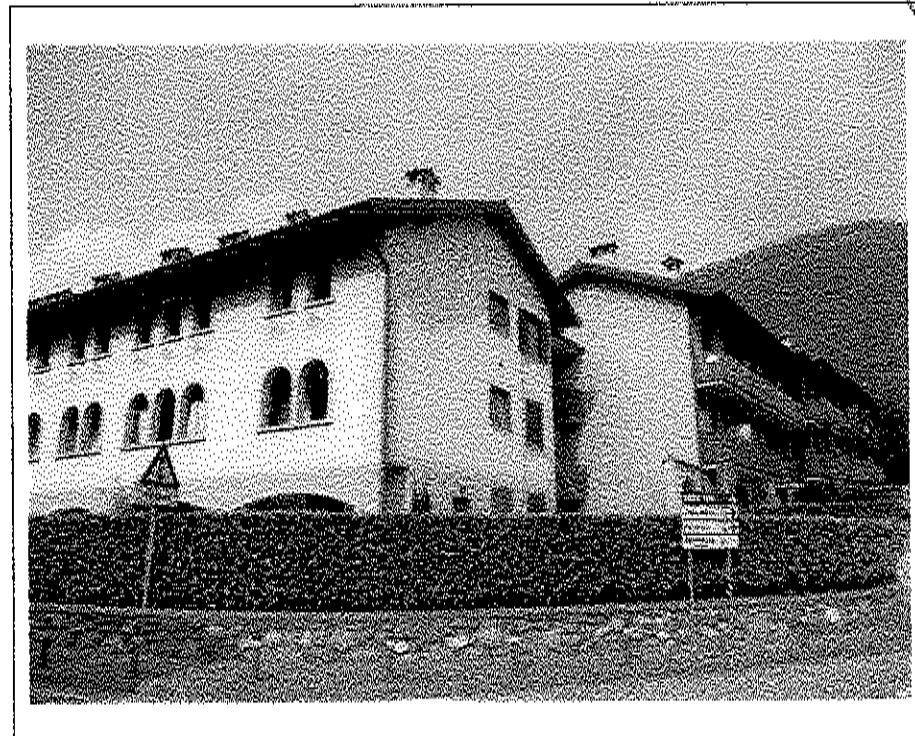
- Lotto n. I05: Vista d'insieme condominio -- Prospetto su Via Moscheni ang. Via Moro -
