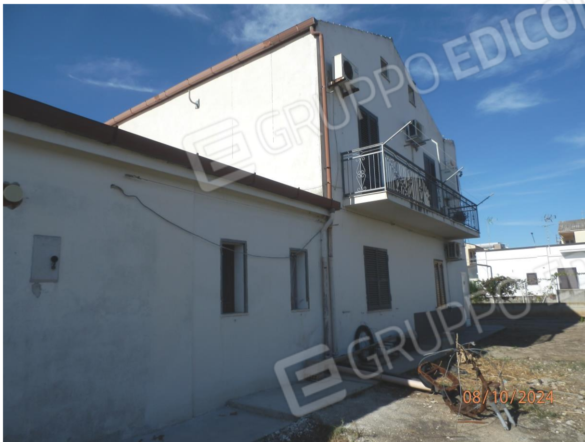
Foto 3 - affaccio posteriore dell'immobile in vendita al piano terra
