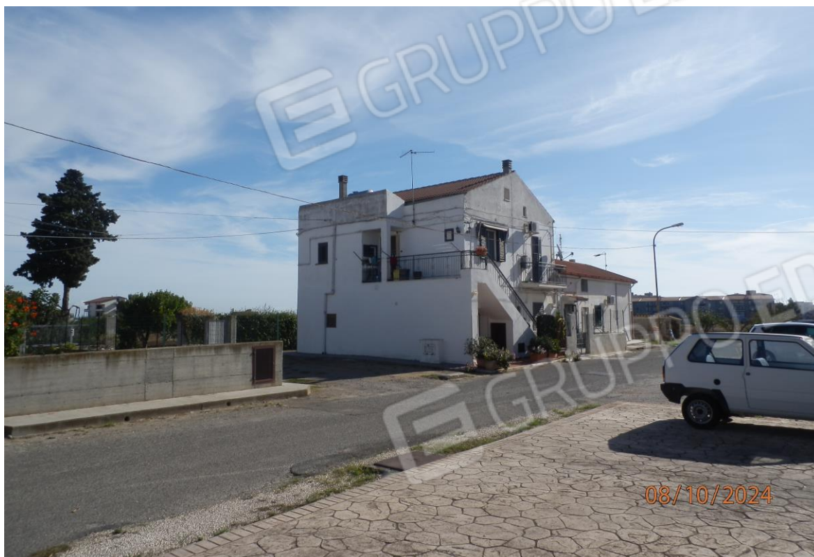
Foto 1 - vista dell'edificio dalla corte comune (via Icco da Taranto)
