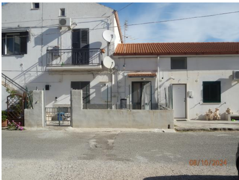
vista esterna lato d'ingresso
