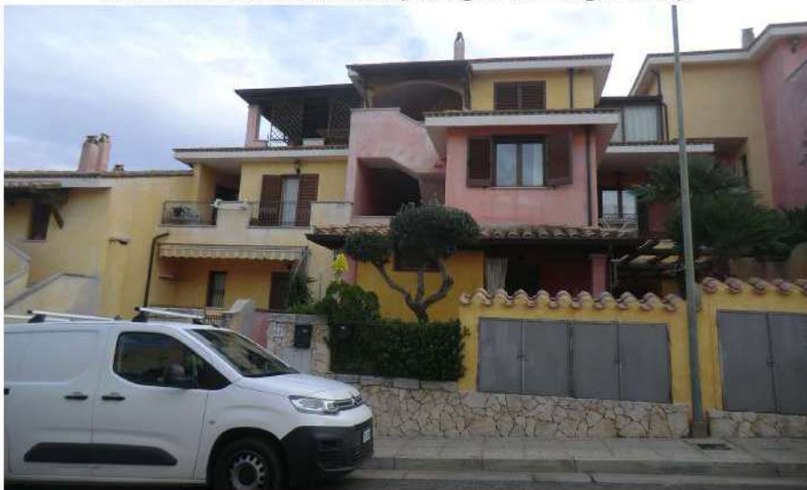
Foto n.2. Via Parigi n.5F- Villasimius. Prospetto principale.
