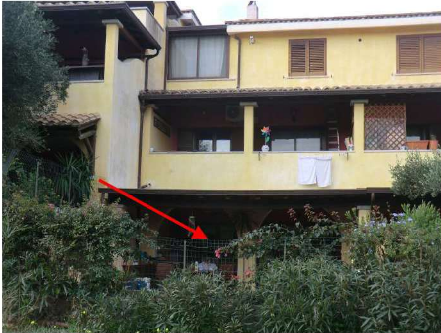
Foto n.3. Via Parigi n.5F - Villasimius. Prospetto posteriore. La freccia indica l'immobile pignorato.
