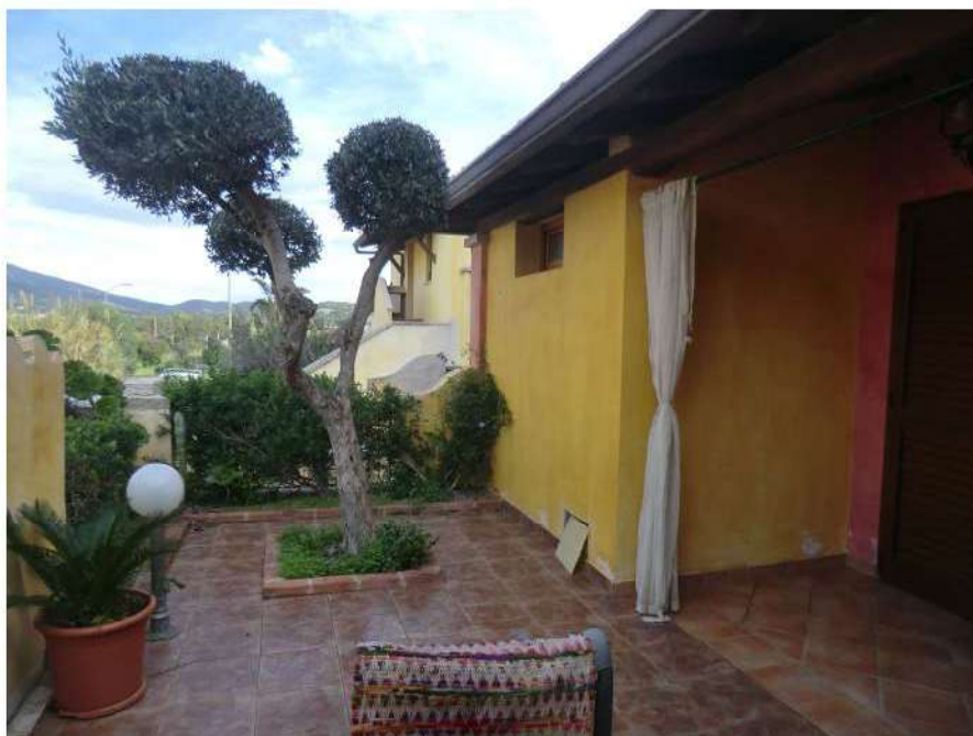
Foto n.18 . Via Parigi n.5F- Villasimius. Cortile lato prospetto principale. E' visibile la tamponatura esterna del bagno realizzato con l'ampliamento successivo.
