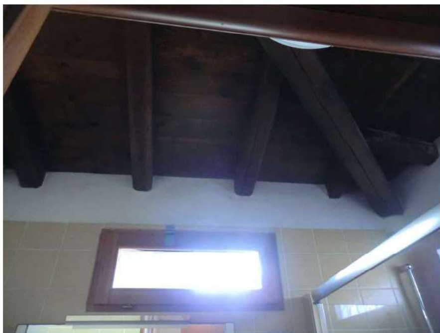
Foto n.17 . Via Parigi n.5F- Villasimius. Bagno realizzato con l'ampliamento successivo. Copertura preesistente.
