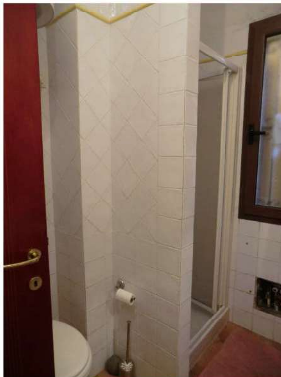
Parigi n.5F- Villasimius. Bagno principale. Parete confinante con la camera
