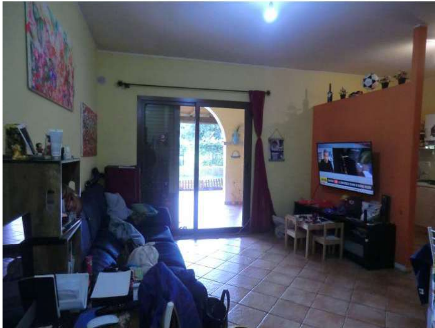
Foto n.4. Via Parigi n.5F- Villasimius. Cucina/Soggiorno. È visibile la quinta in cartongesso realizzata per separare l'angolo cottura dal soggiorno.
