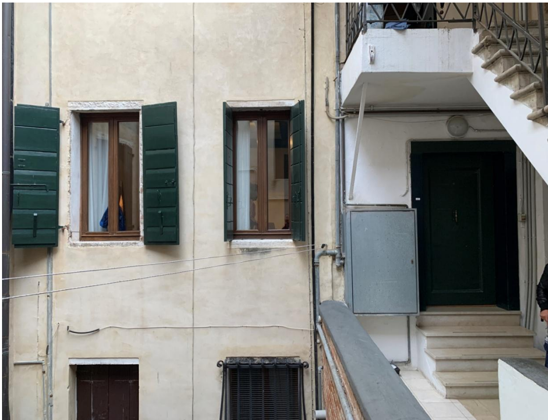
Foto n°6: vista prospetto alloggio su corte interna comune.
