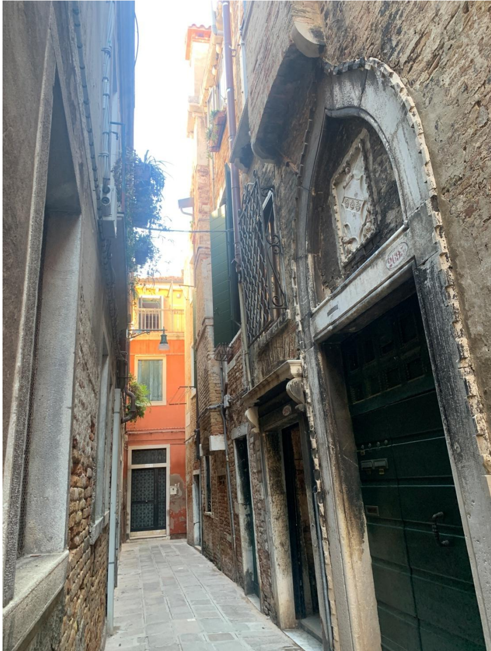
Foto n°1: vista ingresso dalla calle
