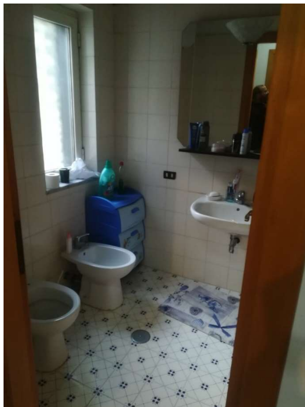
24 | Interno Piano terra Bagno
