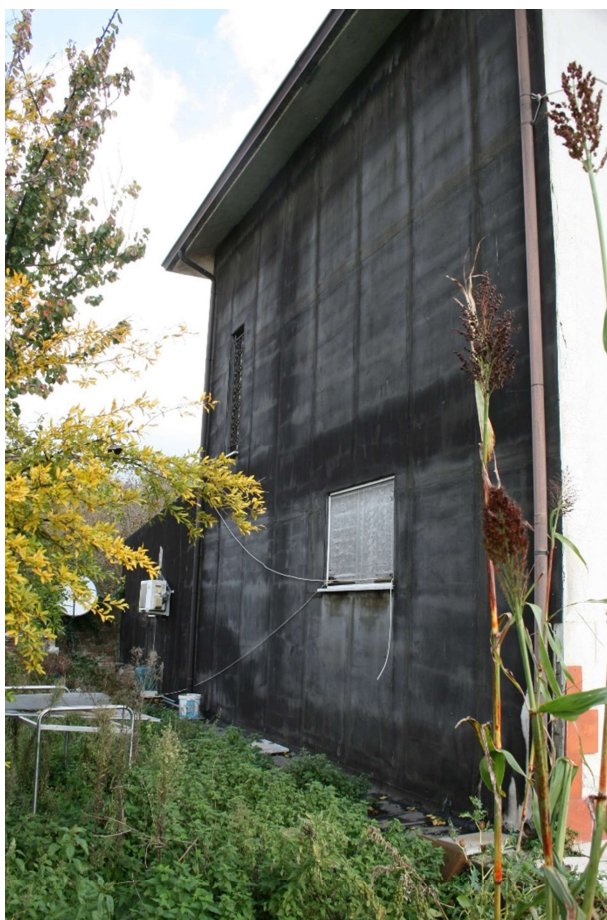
6 | Esterno Vista del fabbricato dalla corte pertinenziale Facciata Ovest
