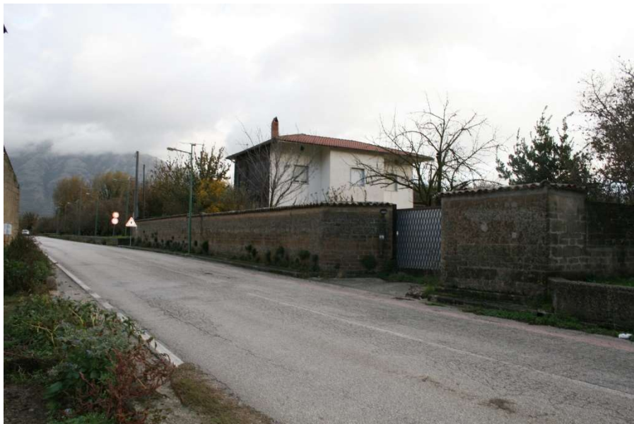
1 | Esterno Accesso all'immobile da Via Torricelli
