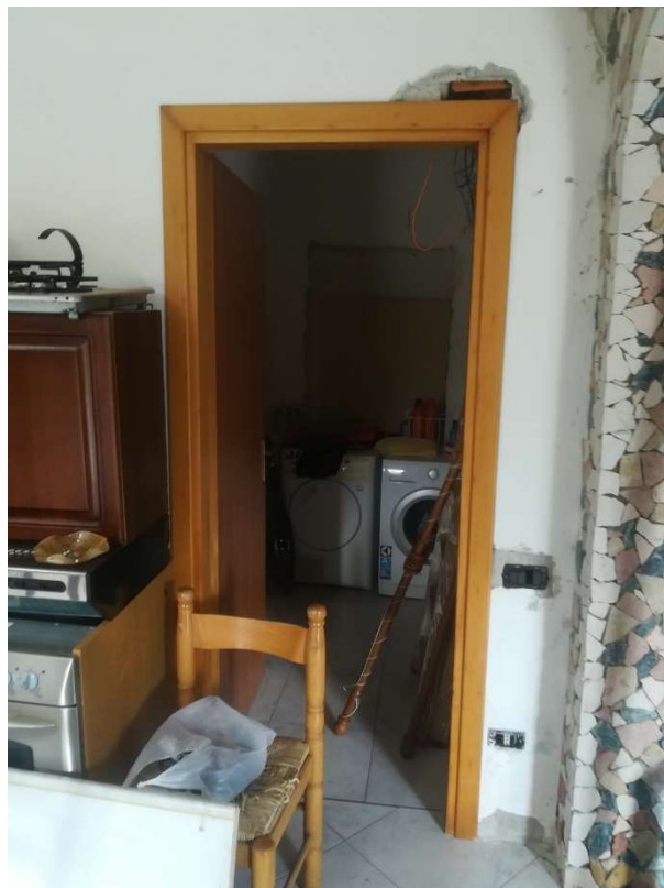
23 | Interno Piano terra Disimpegno
