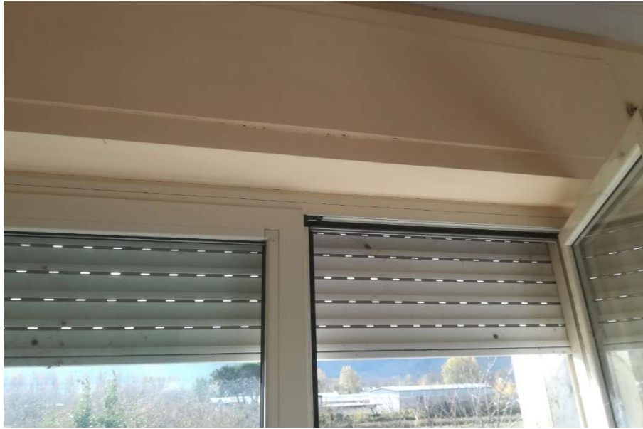
41 | Interno Piano primo Particolare cassonetti in legno e persiane avvolgibili in plastica
