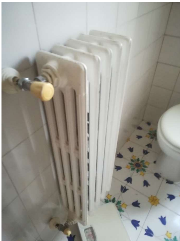
45 | Interno Piano primo Particolare radiatore in ghisa
