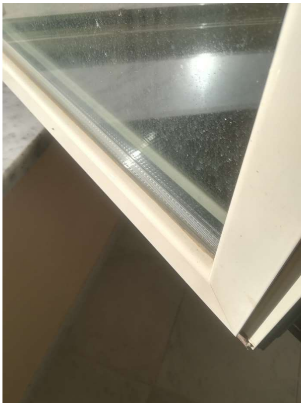
43 | Interno Piano primo Particolare vetro camera in opera sugli infissi
