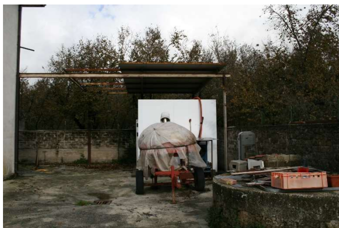
14 | Esterno Vista della corte pertinenziale Particolare tettoia, cella frigorifera e pozzo (angolo Nord/Nord-Est)
