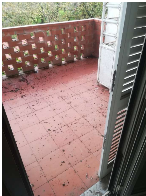
36 | Esterno Piano primo Balcone
