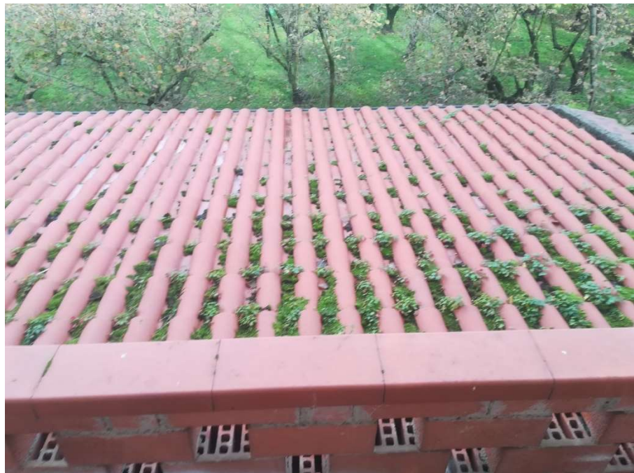
38 | Esterno Piano primo Copertura corpo deposito vista dal balcone
