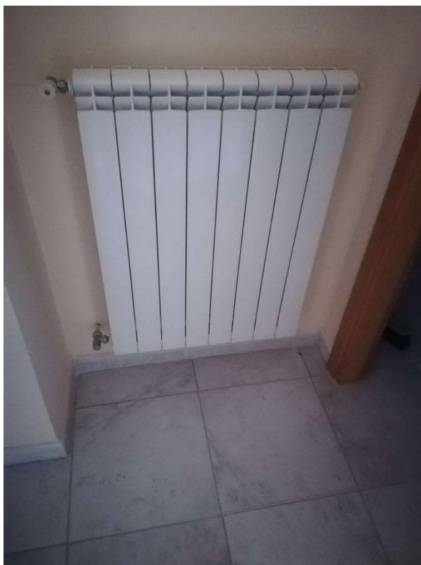
46 | Interno Piano primo Particolare radiatore in ferro
