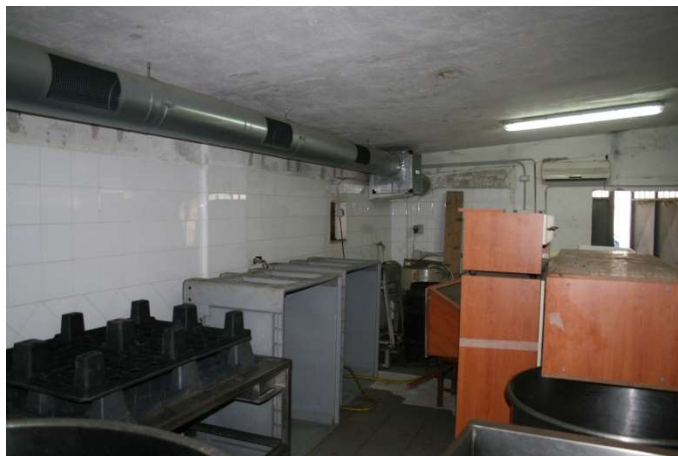
17 | Interno Piano terra Deposito
