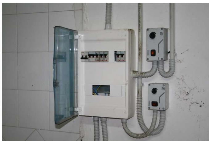
18 | Interno Piano terra Deposito
