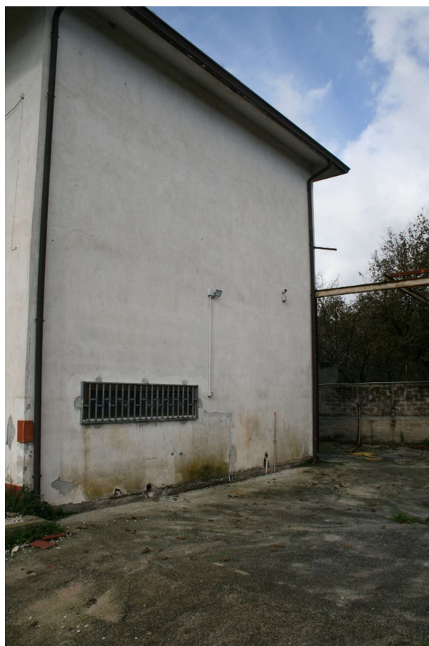
4 | Esterno Vista del fabbricato dalla corte pertinenziale Facciata Est
