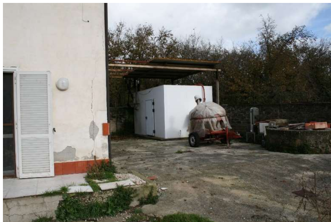
13 | Esterno Vista della corte pertinenziale Particolare tettoia, cella frigorifera e pozzo (angolo Nord/Nord-Est)
