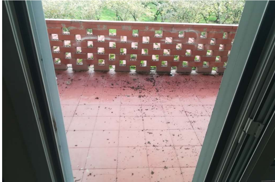
37 | Esterno Piano primo Balcone
