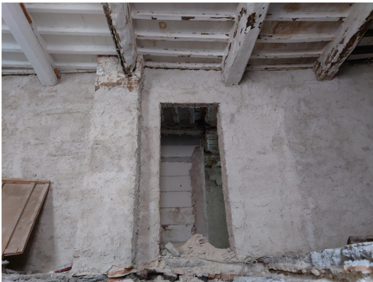
Foto 11 – Vista interna – sub 2 (24/06/2023)
