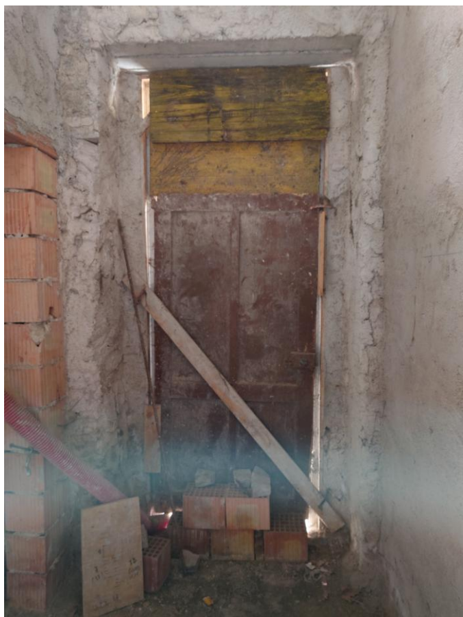
Foto 8 – Vista interna – sub 5 (24/06/2023)
