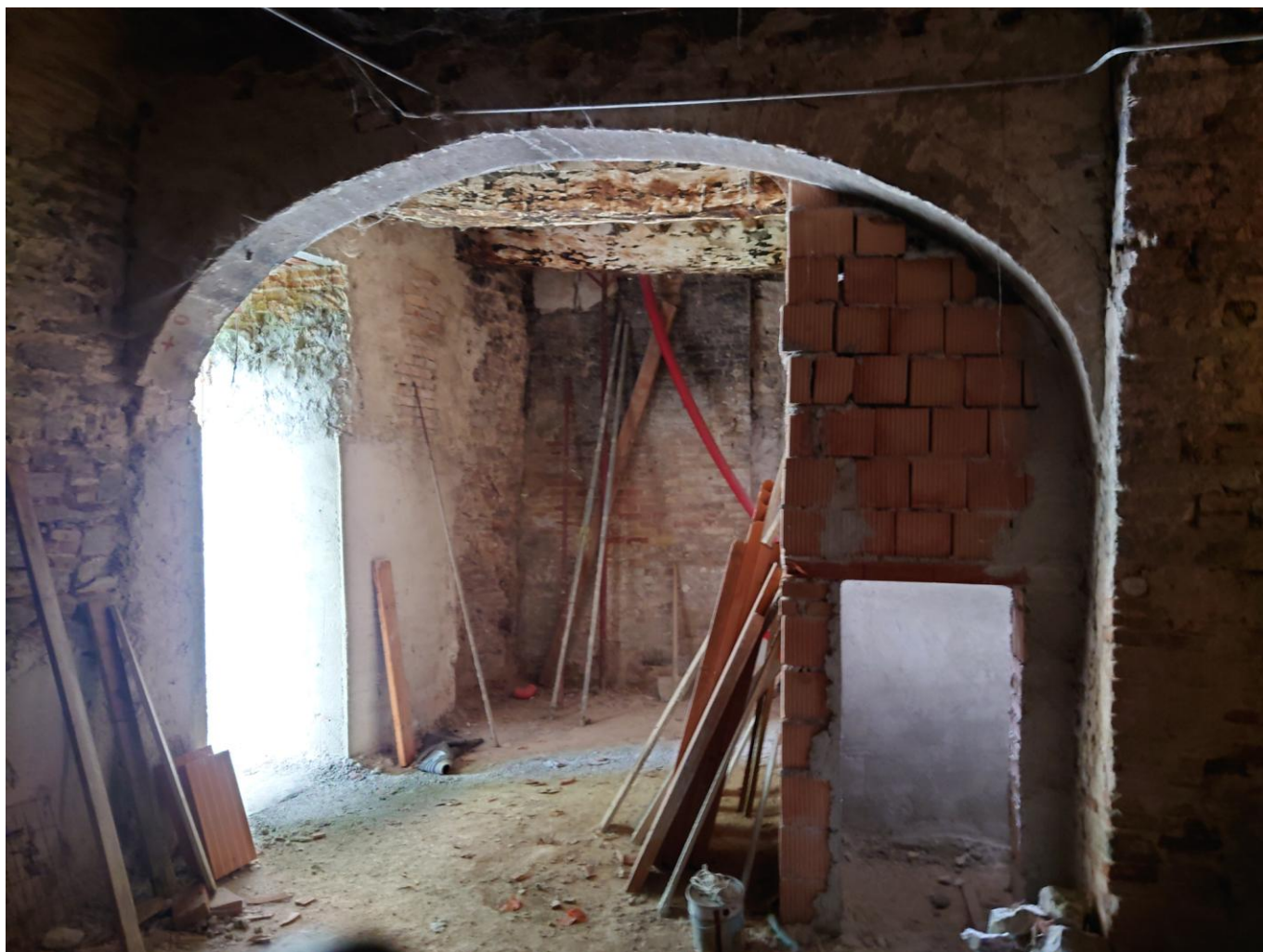
Foto 6 – Vista interna – sub 5 (24/06/2023)
