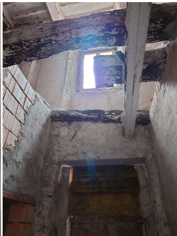
Foto 9 – Vista interna – sub 5 (24/06/2023)
