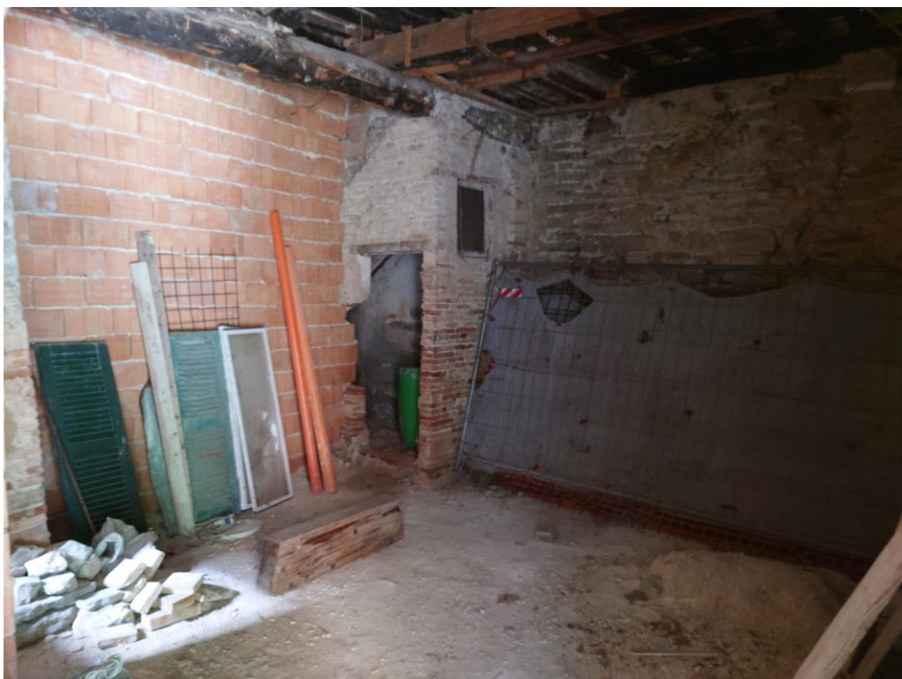
Foto 5 – Vista interna – sub 5 (24/06/2023)
