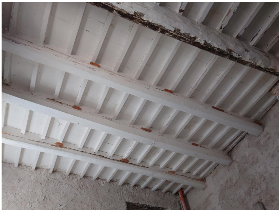
Foto 13 – Dettaglio solaio superiore – sub 2 (24/06/2023)
