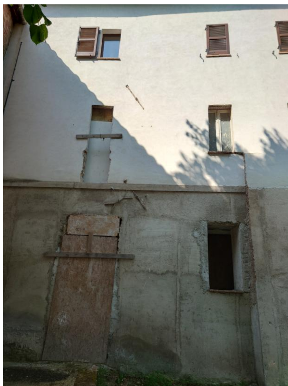
Foto 3 – Vista esterna immobile (29/05/2023)
