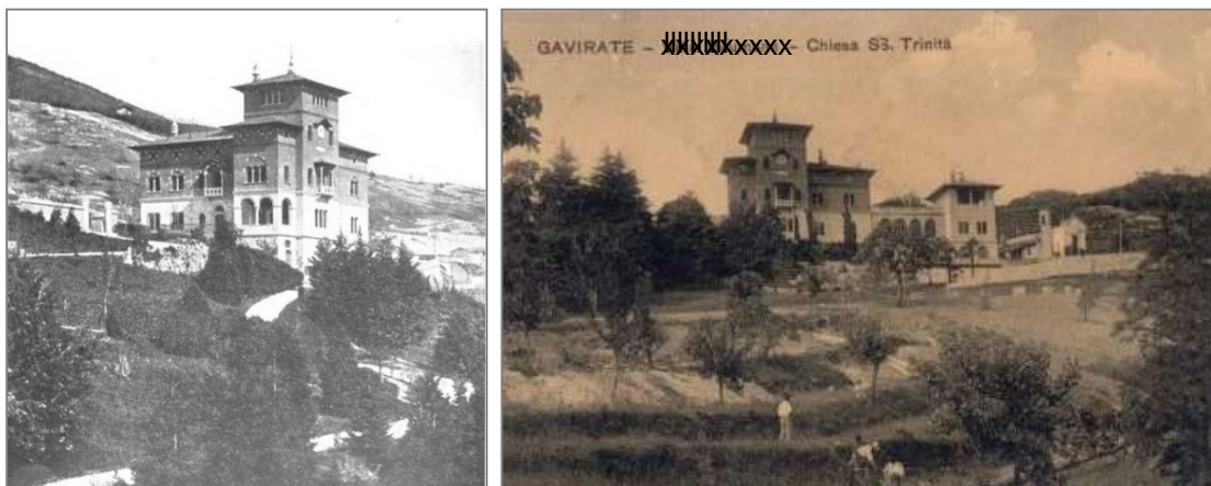
in foto storiche prima e dopo l'ampliamento avvenuto nei primi del secolo scorso
