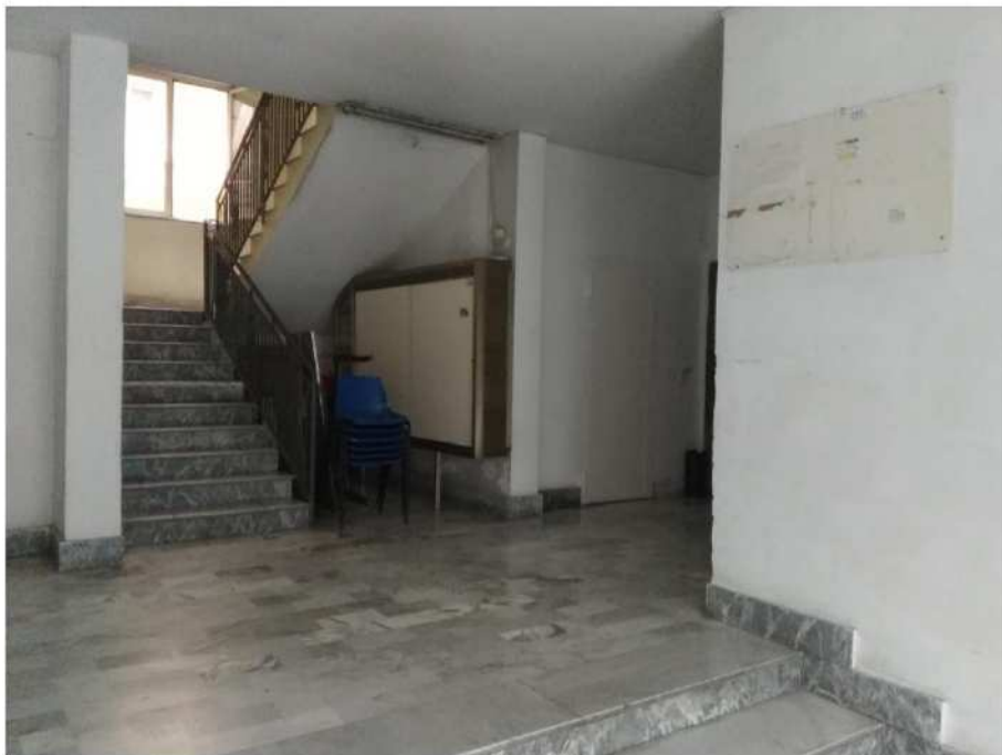
Foto n. 4 – Androne del fabbricato
