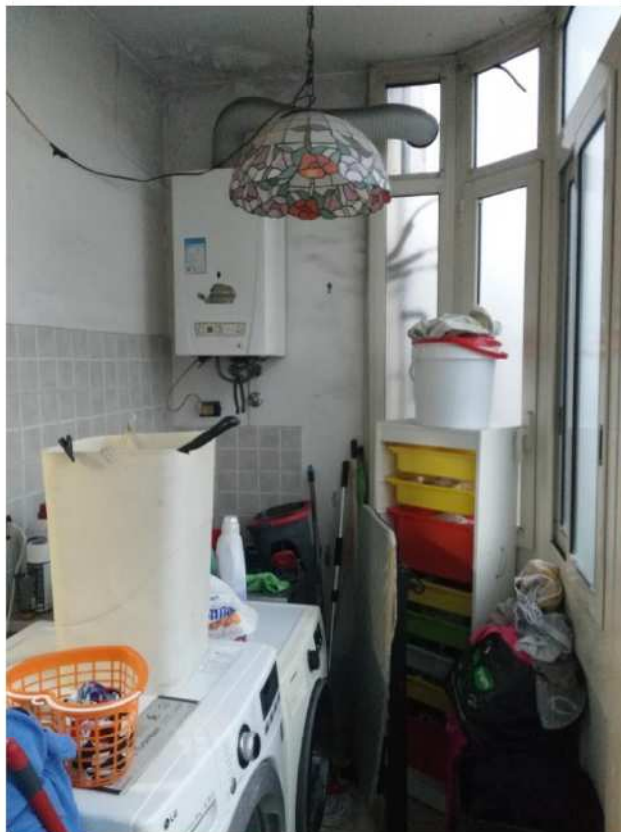
Foto n. 20 – Balcone n.2 (veranda)
