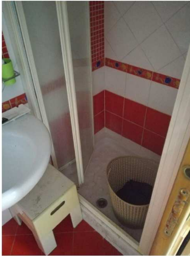
Foto n. 47 – Camera n.2 – Bagno n. 2
