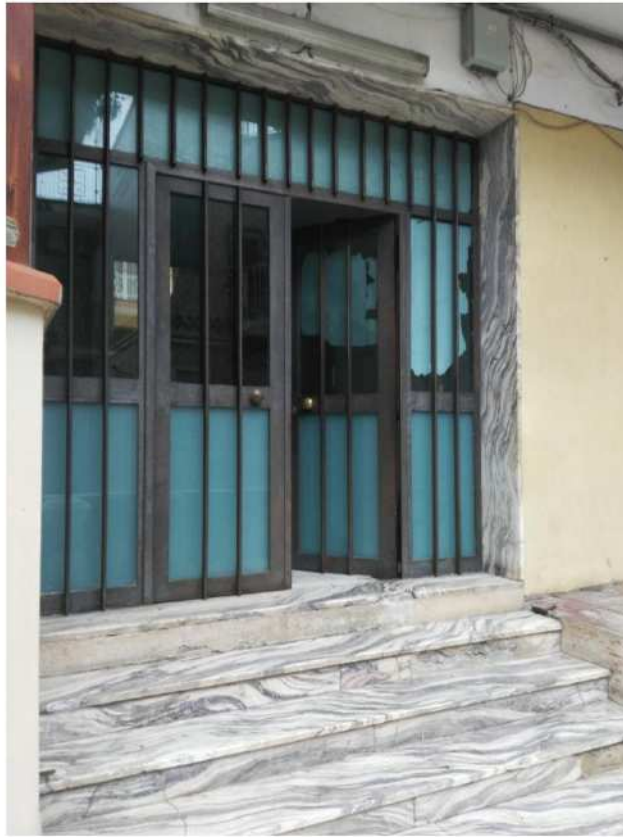
Foto n. 23 – Ingresso alla scala
