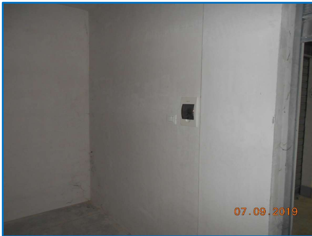
FOTO N.46: box sub 204 e deposito sub 203 - Lotto n.27.
