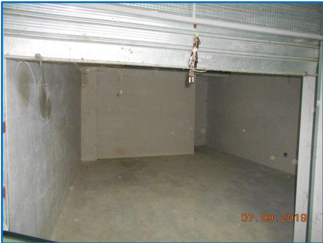
FOTO N.44: box sub 204 e deposito sub 203 - Lotto n.27.
