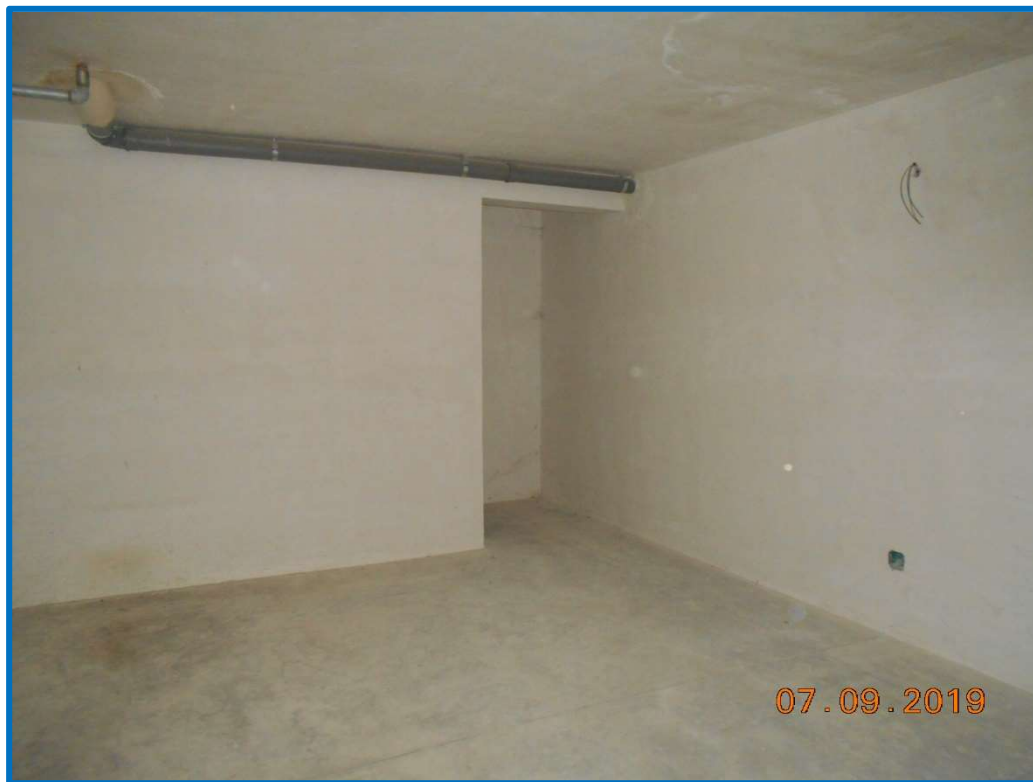
FOTO N.45: box sub 204 e deposito sub 203 - Lotto n.27.
