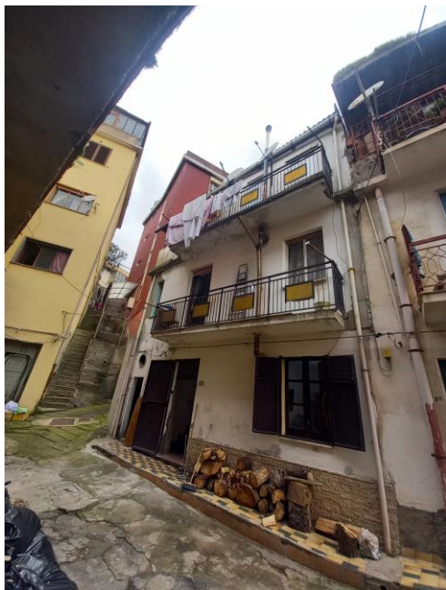
Foto 3- 4 Prospetto su via Via Monte Poro
