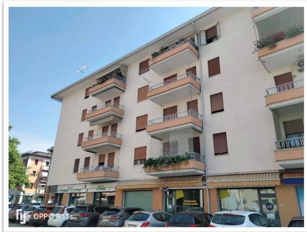
Figura 10 - Fabbricato, affaccio su Piazza De Gasperi
