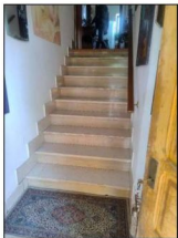
scala interna di accesso al primo piano
