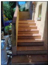
scala di accesso al primo piano
