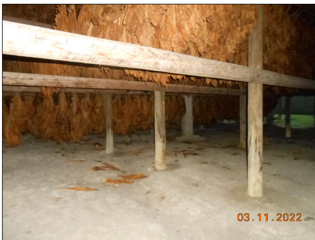
FOTO N. 52 Particolare dei pali cementati alla base. Capanna adibita a stenditoio per il tabacco, fg. 3 p.Ila 435/8.
