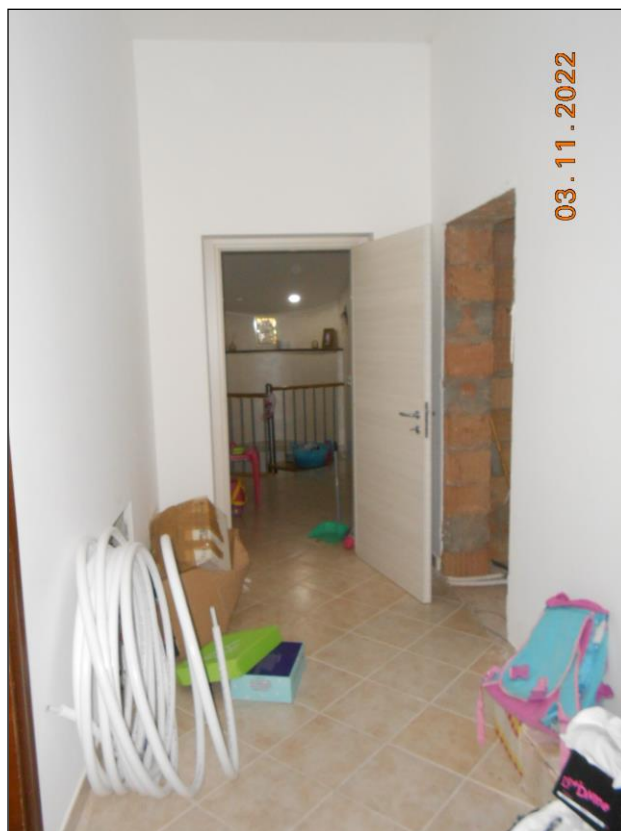
FOTO N. 39 Vista del piano sottotetto dell'immobile pignorato, variato in mansarda.
