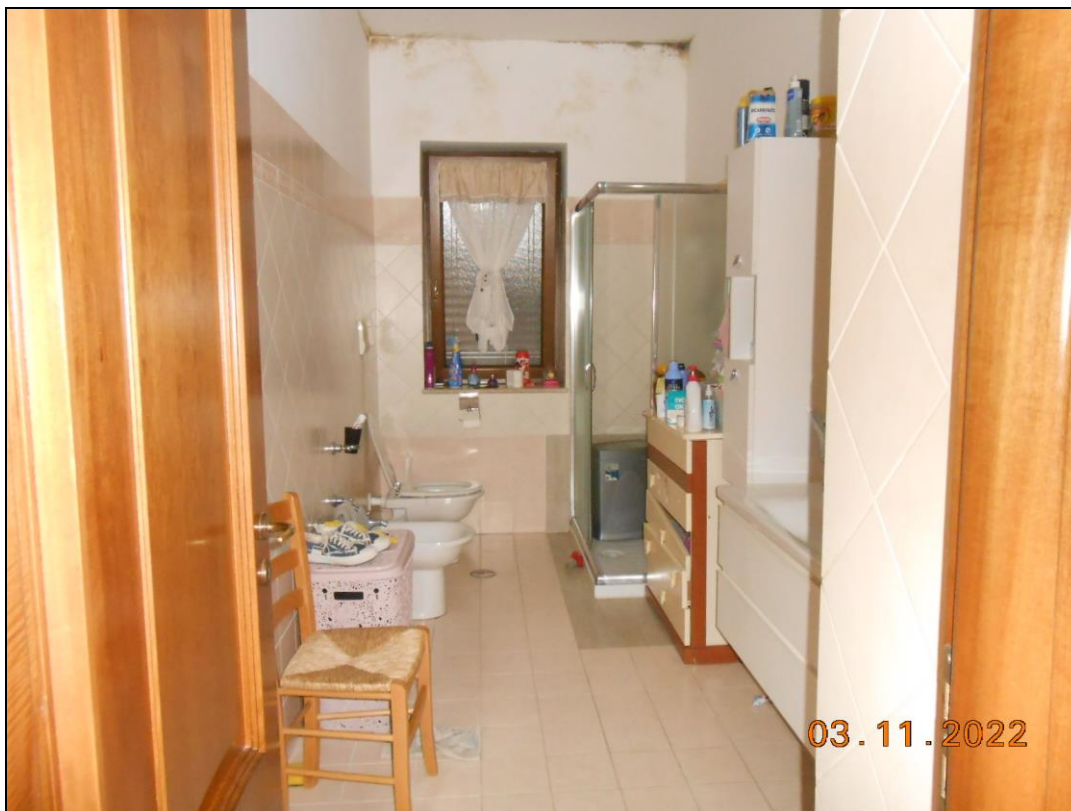
FOTO N. 21 Vista interna a piano terra dell'immobile pignorato. Si notano macchie di condensa sulle pareti e negli angoli.
