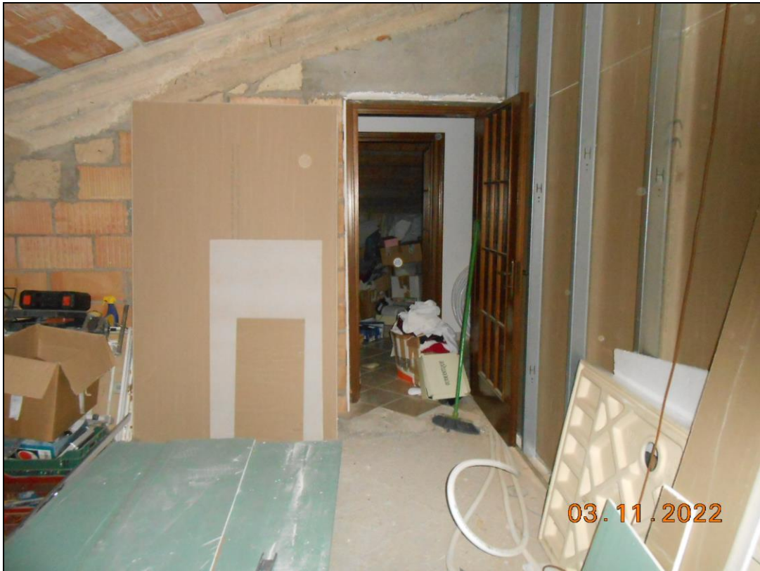
FOTO N. 35 Vista del piano sottotetto dell'immobile pignorato, variato in mansarda. Si nota la parte allo stato rustico.
