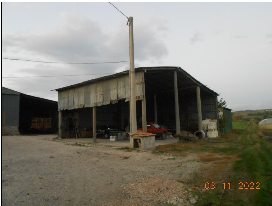
FOTO N. 41 Vista della capanna in lamiera, per il ricovero di mezzi, fg. 3 p.la 435/8.
