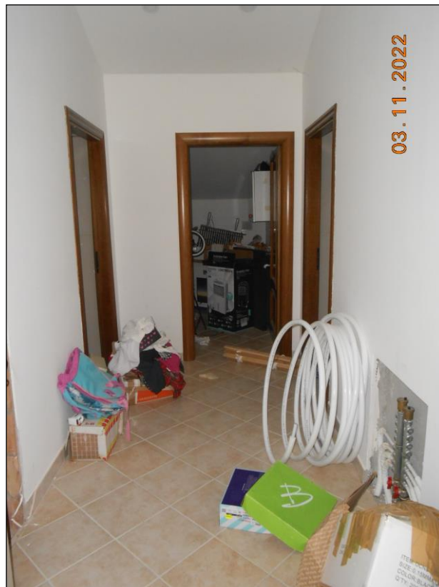
FOTO N. 30 Vista del piano sottotetto dell'immobile pignorato, variato in mansarda.
