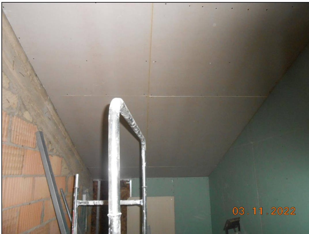
FOTO N. 31 Vista del piano sottotetto dell'immobile pignorato, variato in mansarda. Si nota la parte in fase di completamento.
