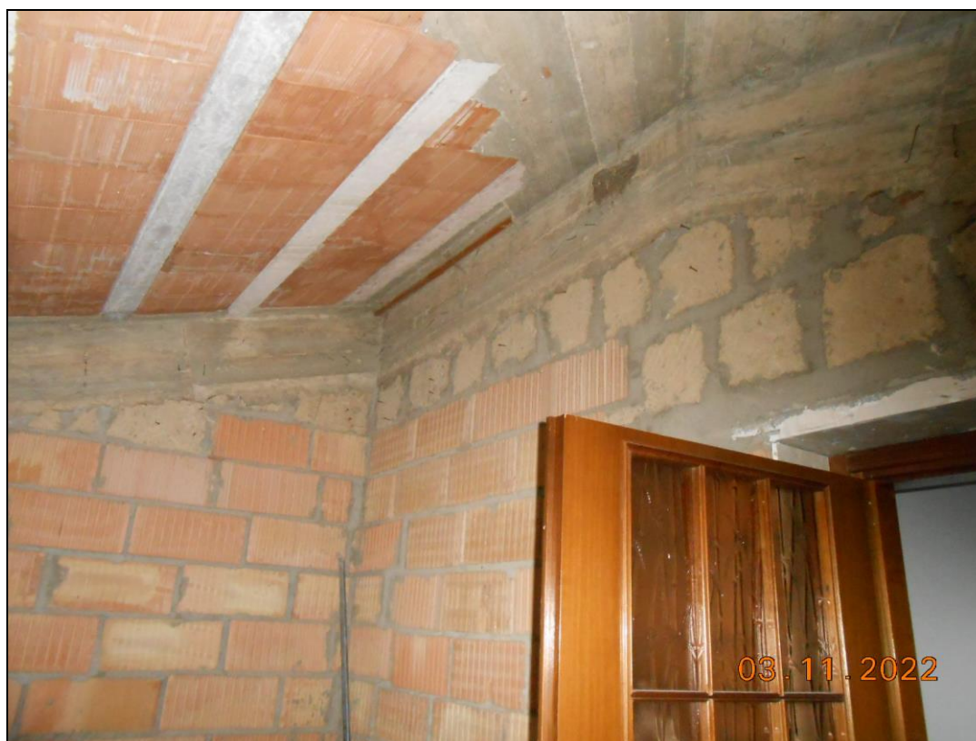
FOTO N. 38 Vista del piano sottotetto dell'immobile pignorato, variato in mansarda. Si nota la parte allo stato rustico.
