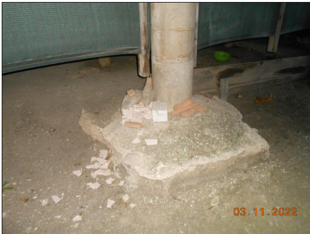
FOTO N. 51 Particolare dei pali di cemento vibro compressi cementati alla base. Capanna adibita a stenditoio per il tabacco, fg. 3 p.Ila 435/8.
