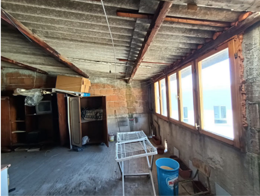
Foto 13 - Piano secondo, terrazzo coperto
