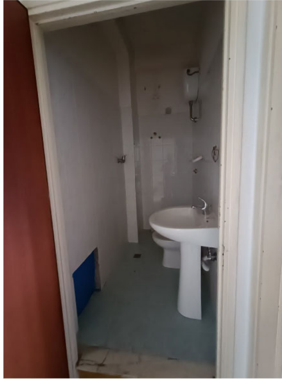
Foto 9 - Piano primo, bagno
