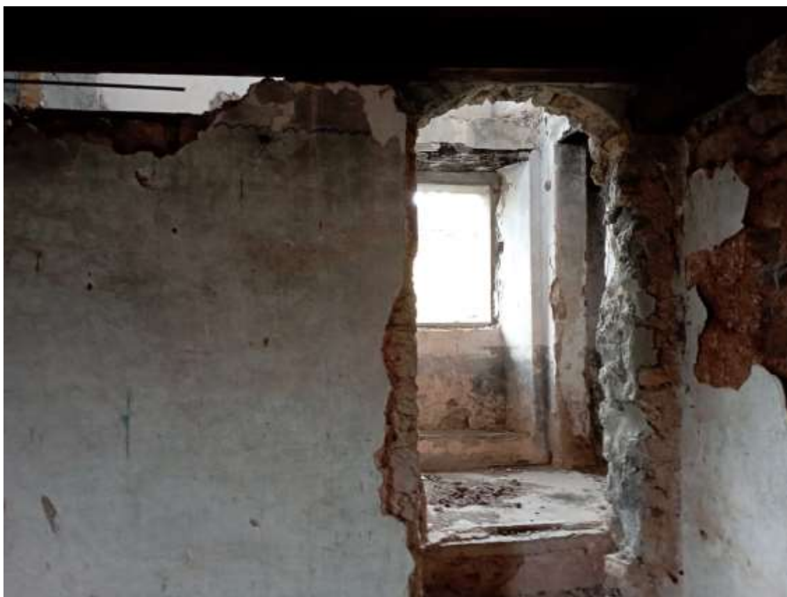
Figura 6 il varco di collegamento tra i locali del piano primo
