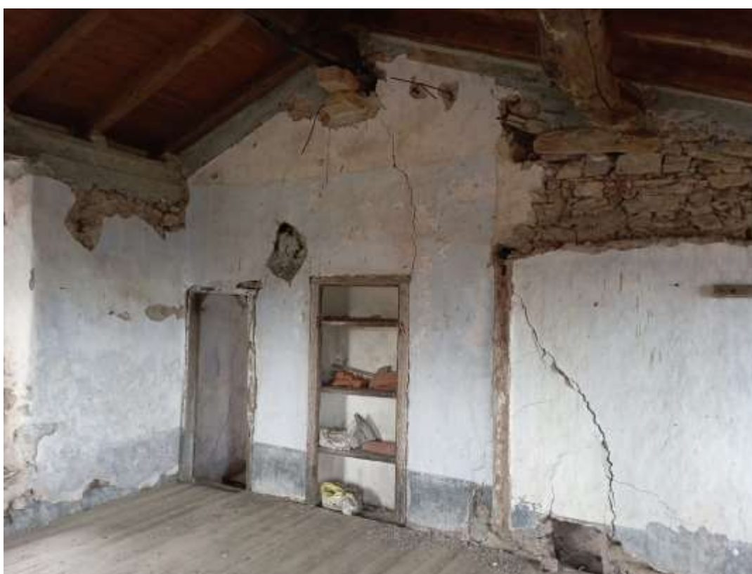
Figura 8 interni al piano secondo
