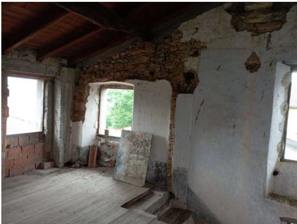
Figura 9 interni al piano secondo
