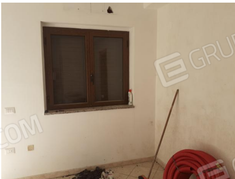
Foto n. 12: Piano terra dell'unità immobiliare censita in catasto fabbricati del comune di Nocera Terinese al foglio di mappa 45, particella 422, sub 6.
