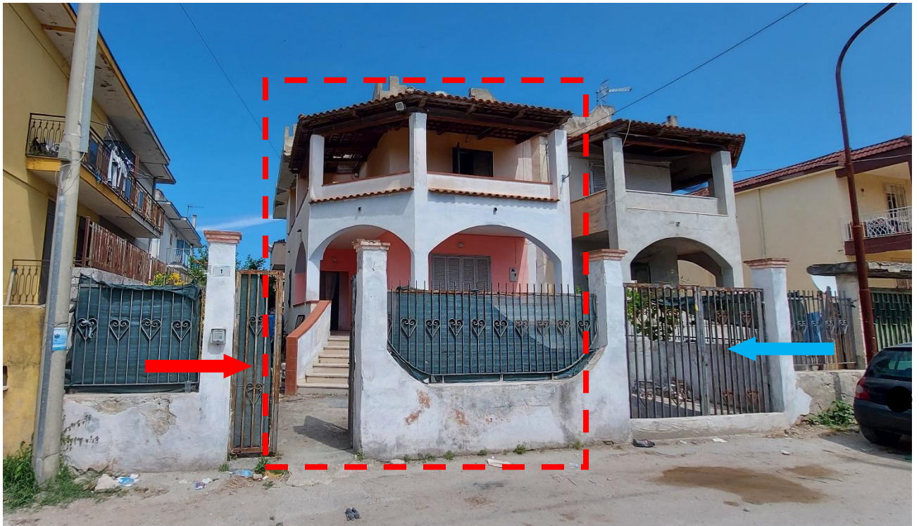
Via Catania – indicazione fabbricato cespite ed accessi pedonale (rosso) e carrabile (celeste)
