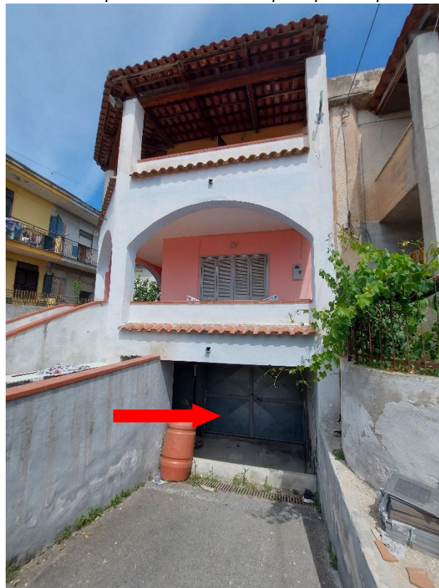
rampa e accesso piano seminterrato
