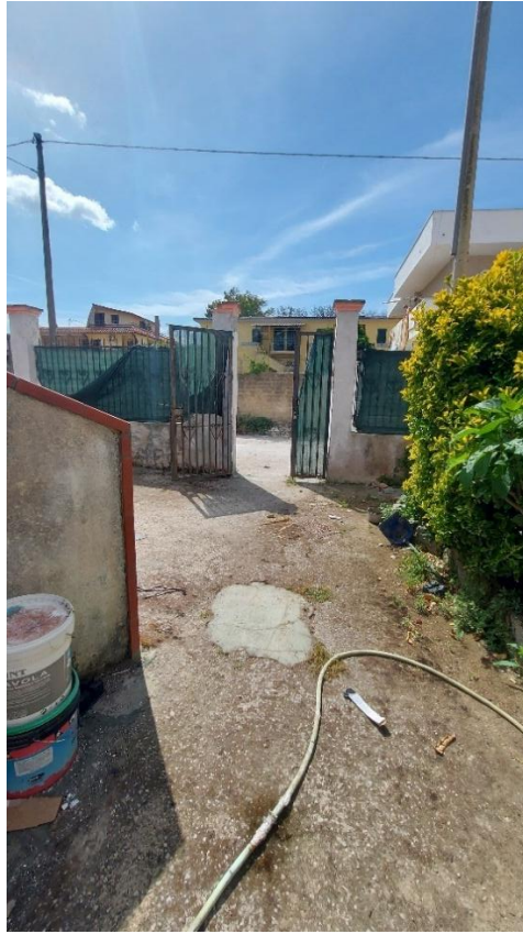
Area di pertinenza (sud-est)- accesso pedonale
