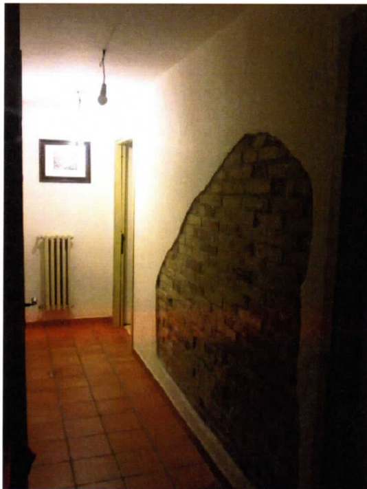
FOTO "A" Zona di demolizione scala interna
