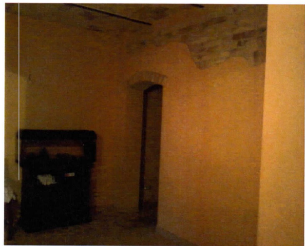
FOTO "B" Zona demolizione scala
