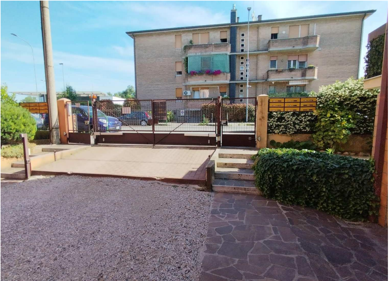
Veduta esterna del vialetto di ingresso condominiale
