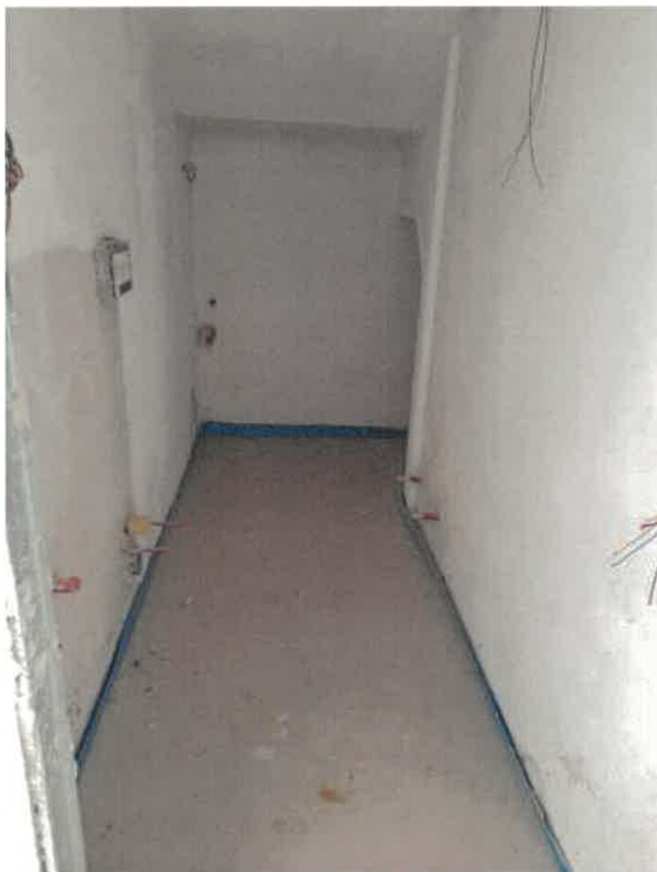
Bagno e rip. sottoscala
