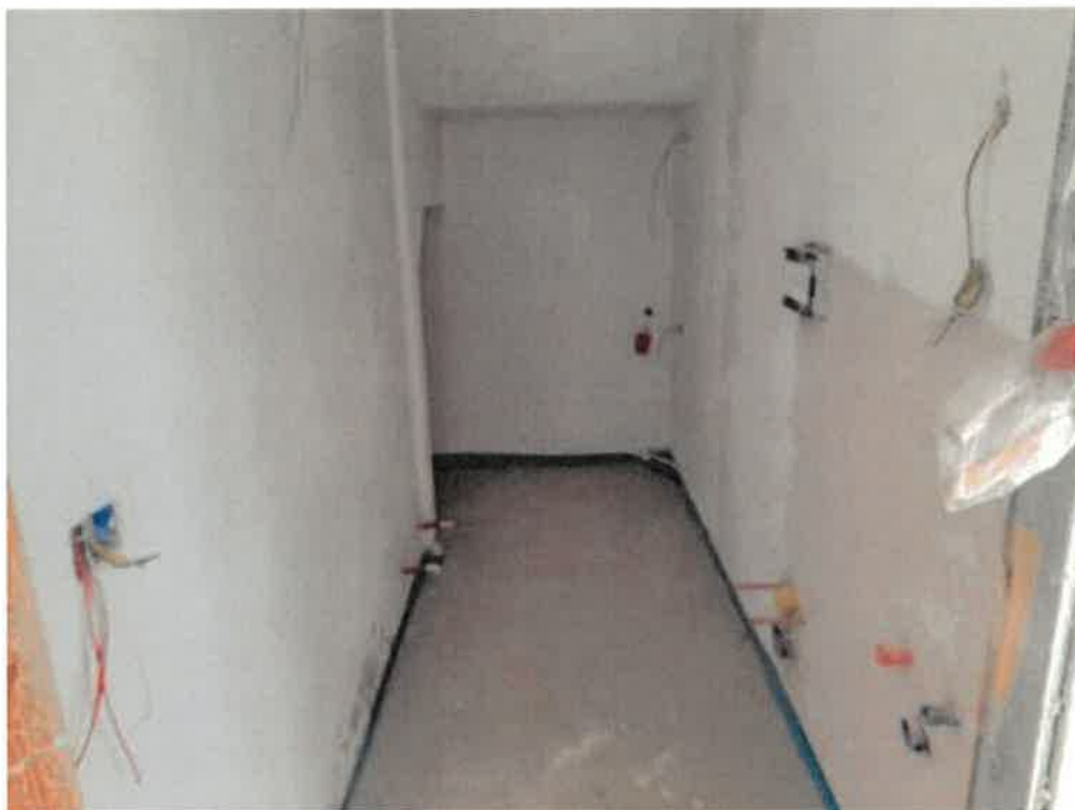
Bagno e rip. sottoscala
