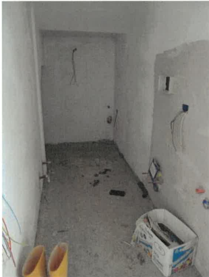
Bagno e rip. sottoscala
