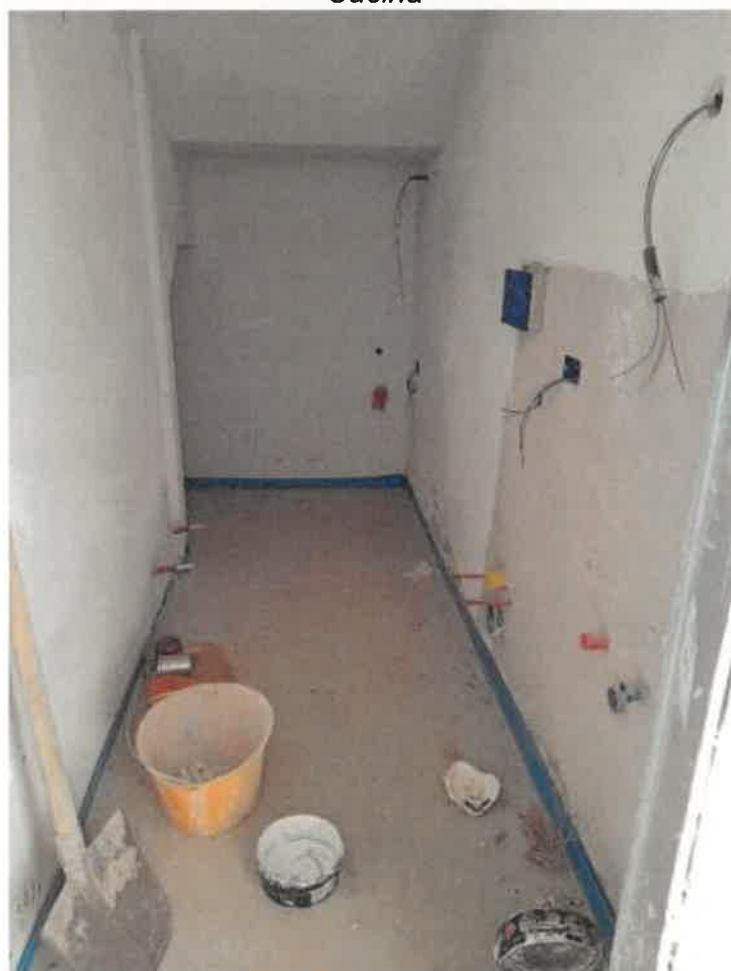
Bagno e rip. sottoscala
