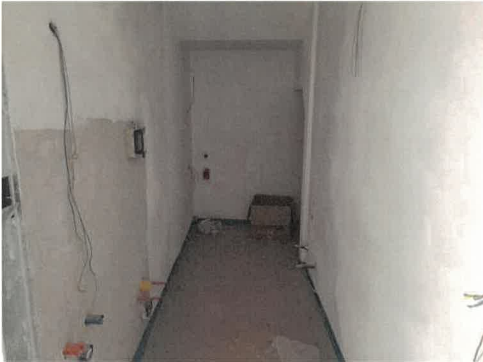
Bagno e rip. sottoscala
