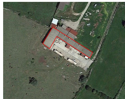
Figura 4 – vista dettagliata fabbricati
