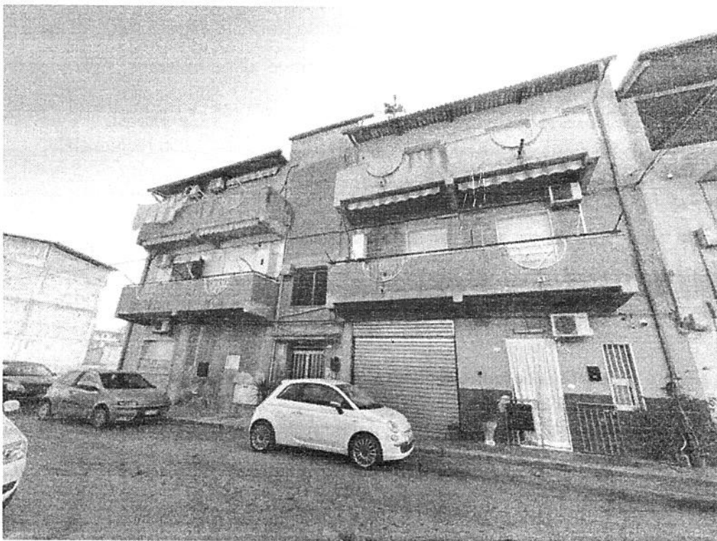
Foto 2 – Prospetto principale dell'immobile su via Parnaso
