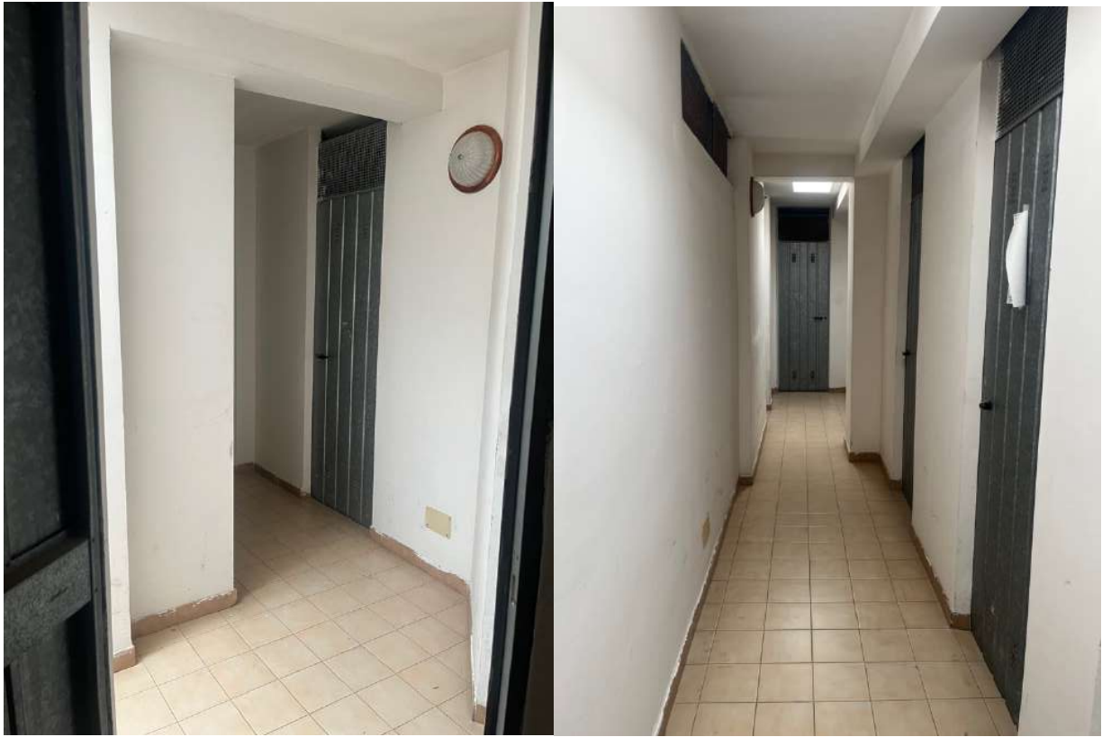
Foto 26 e 27 Corridoio di accesso alle cantine
