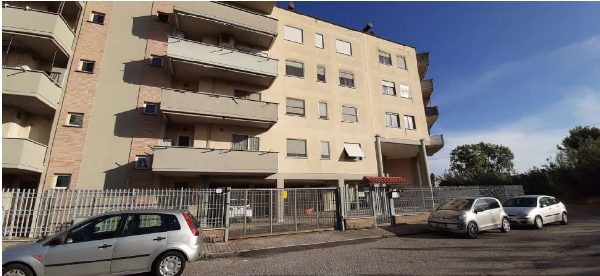
Foto 2 Vista esterna edificio al civico 2, scala B sulla destra
