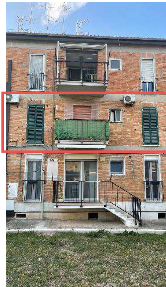
Foto 04 – Esterno – facciata posteriore - dettaglio infissi
