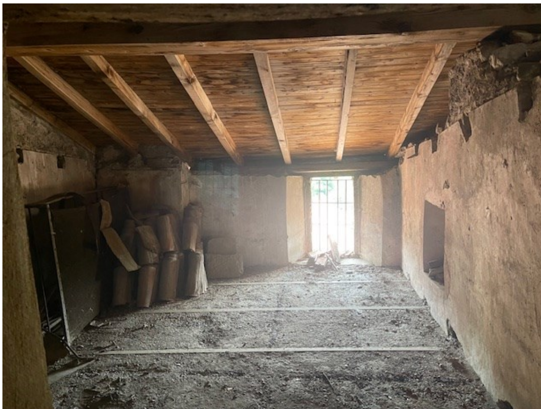
Foto 12 - Piano sottotetto (porzione a sud)
