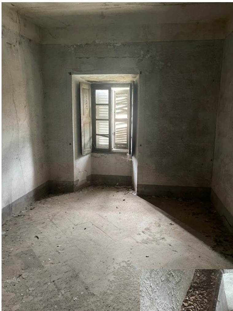
Foto 10 – Piano primo – Camera
