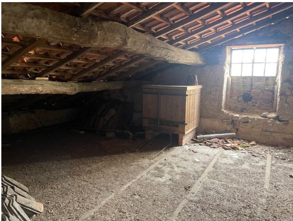
Foto 13 - Piano sottotetto (porzione a nord)
