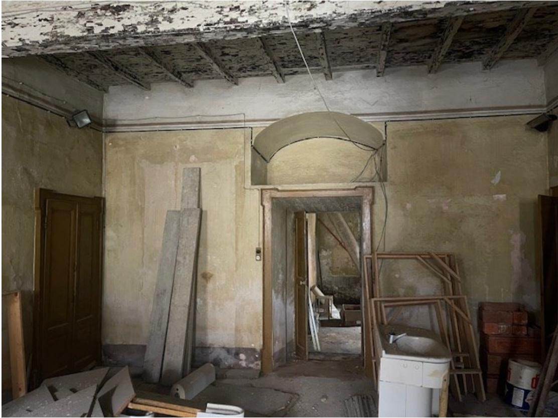
Foto 3 e 4 - Piano terra (locale con camino)
