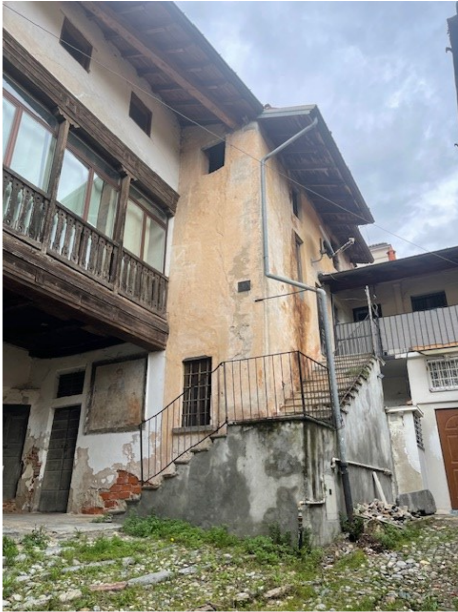
Foto 2 - Prospetto sud (su corte comune)
