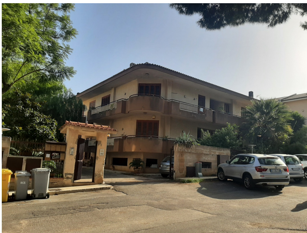
Via delle Alpi n.8 – Individuazione del fabbricato (p.Ila 4052) – Prospetto su strada
