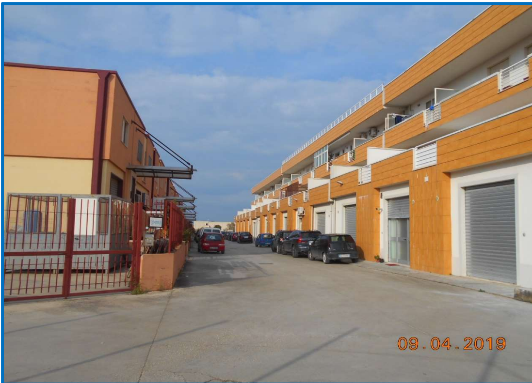
FOTO N.2: vista del fronte N-O del blocco di via delle Casermette dove sono ubicati i lotti nn.5, 6, 7, 8.
