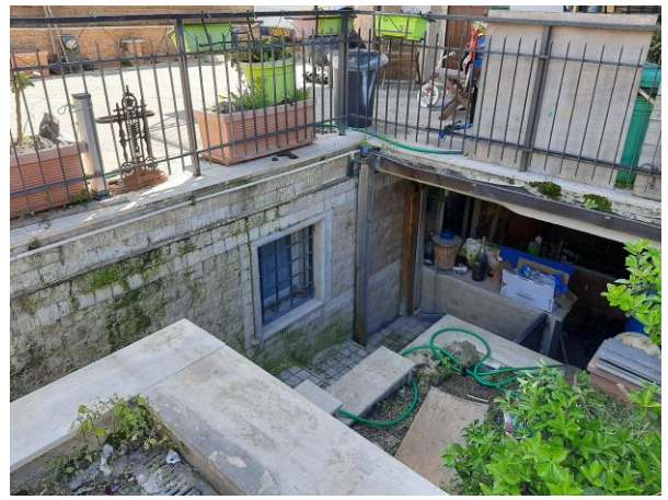
Modifiche alla rampa del garage
