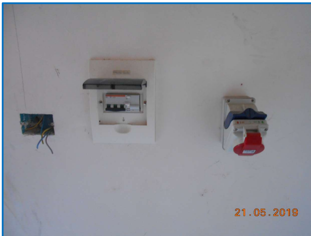
FOTO N.14: particolare interno dell'immobile in piano terra sub 28 – Lotto n.7.
