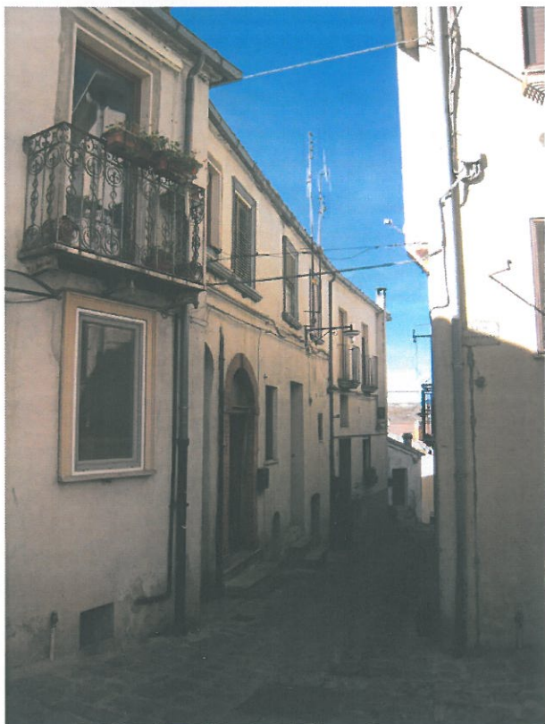
Foto 1 – prospetto su via Pisacane
