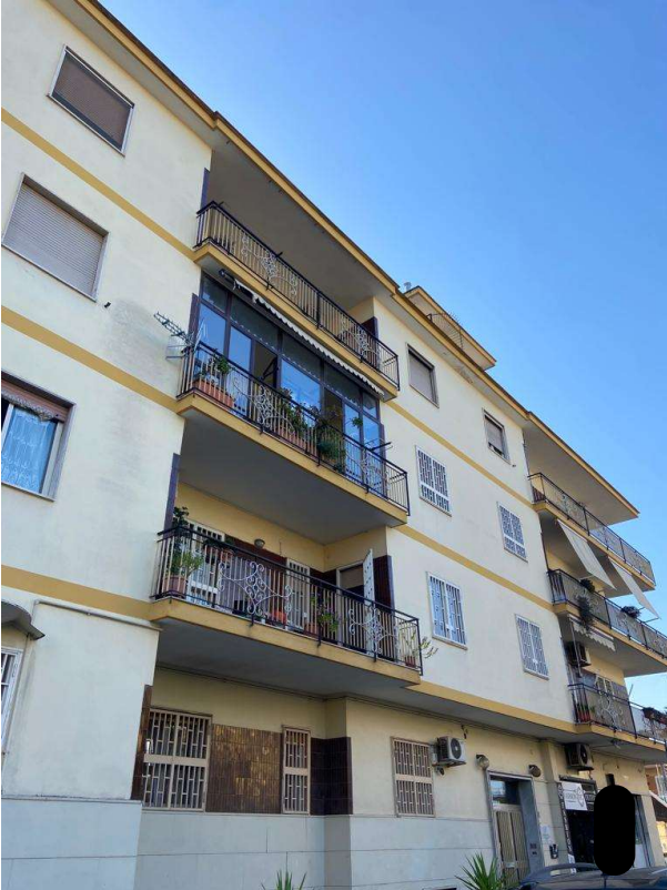
Foto 1 Facciata d' ingresso fabbricato lato est
