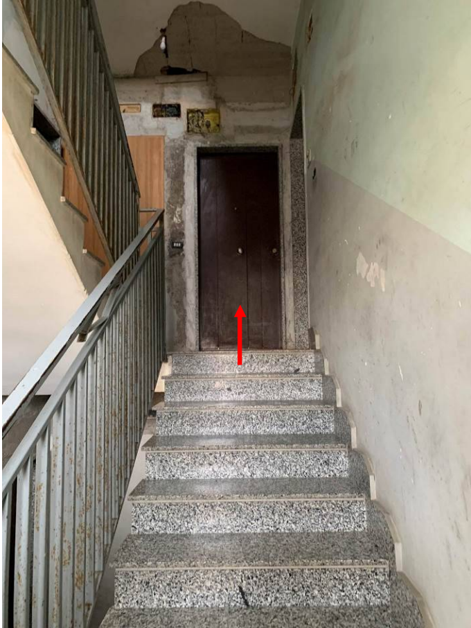
Foto 06 – Le scale e l'ingresso all'appartamento
