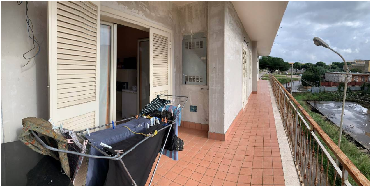
Foto 19 – Il balcone b
