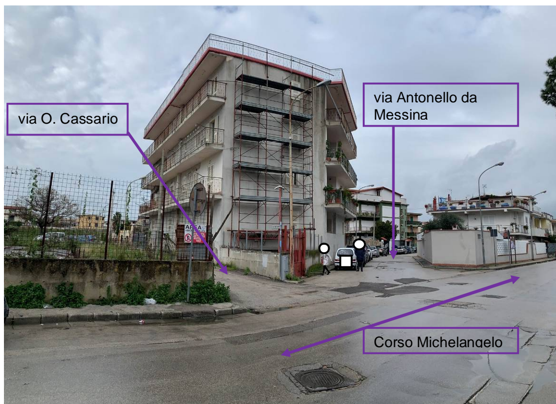
Foto 02 – Il fabbricato dal Corso Michelangelo
