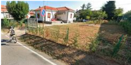
vista complesso da Via Cassano Magnago
