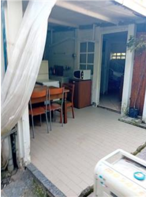
Tettoia Accessorio Deposito usata impropriamente ad uso residenziale
