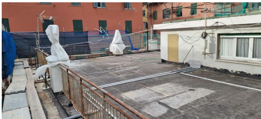
Foto n. 17 – copertura del civico
