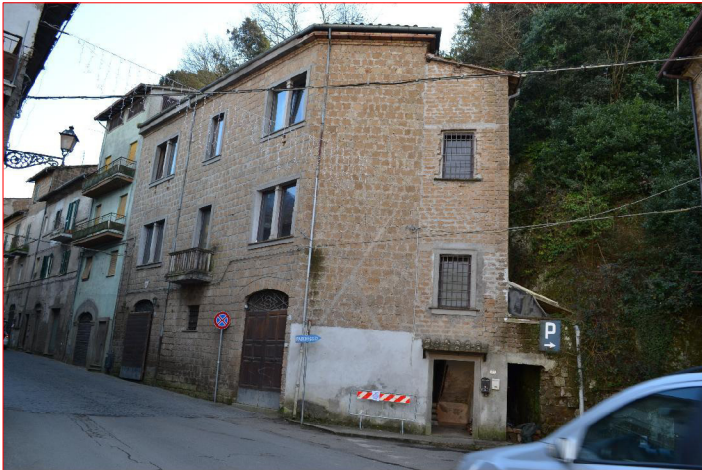
vista esterna da nord
