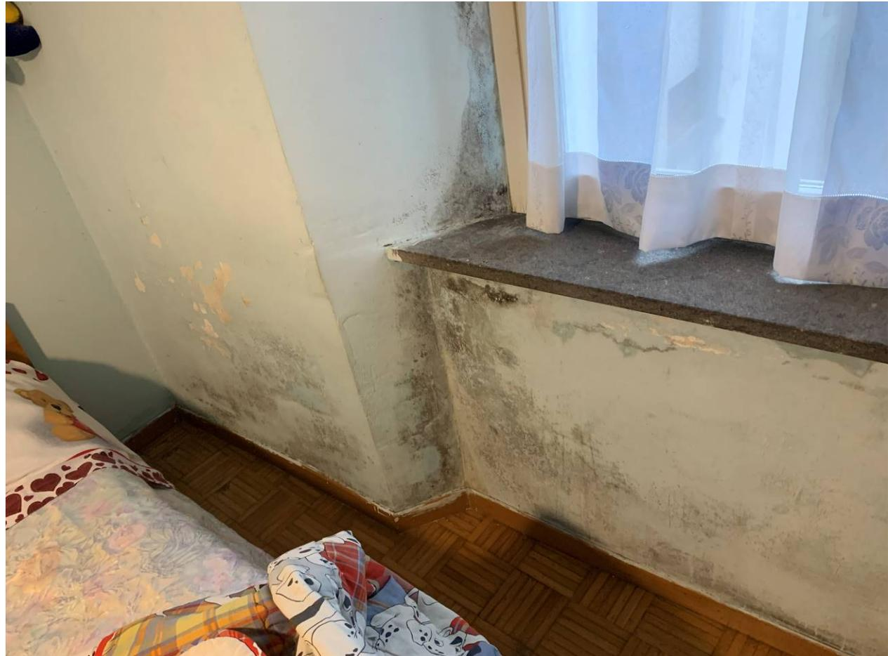
10. Dettaglio dello stato di conservazione degli intonaci in corrispondenza delle murature perimetrali
