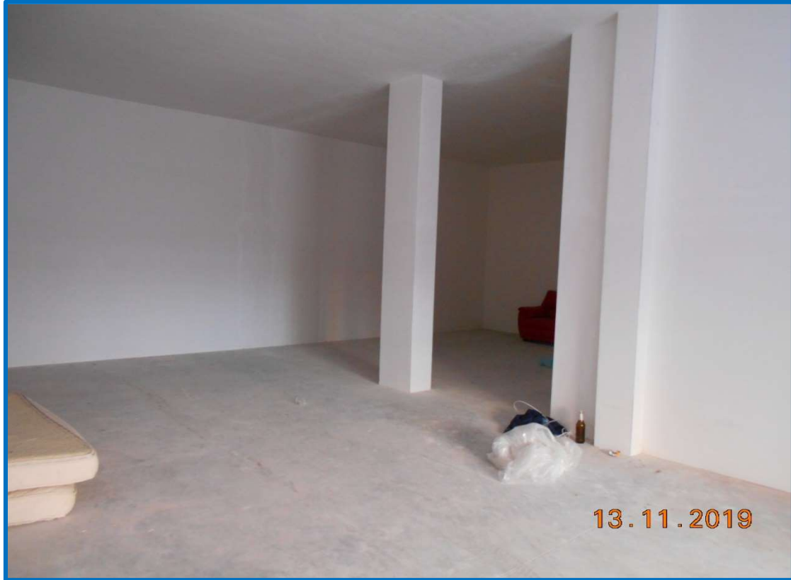
FOTO N.5: interni immobile in piano terra sub 26 – Lotto n.5.
