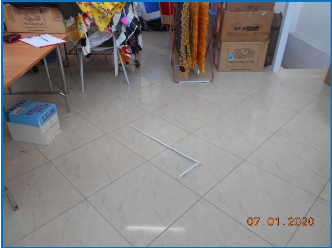
FOTO N.19: interni piano terra dell'immobile in sub 18 – lotto n.4
