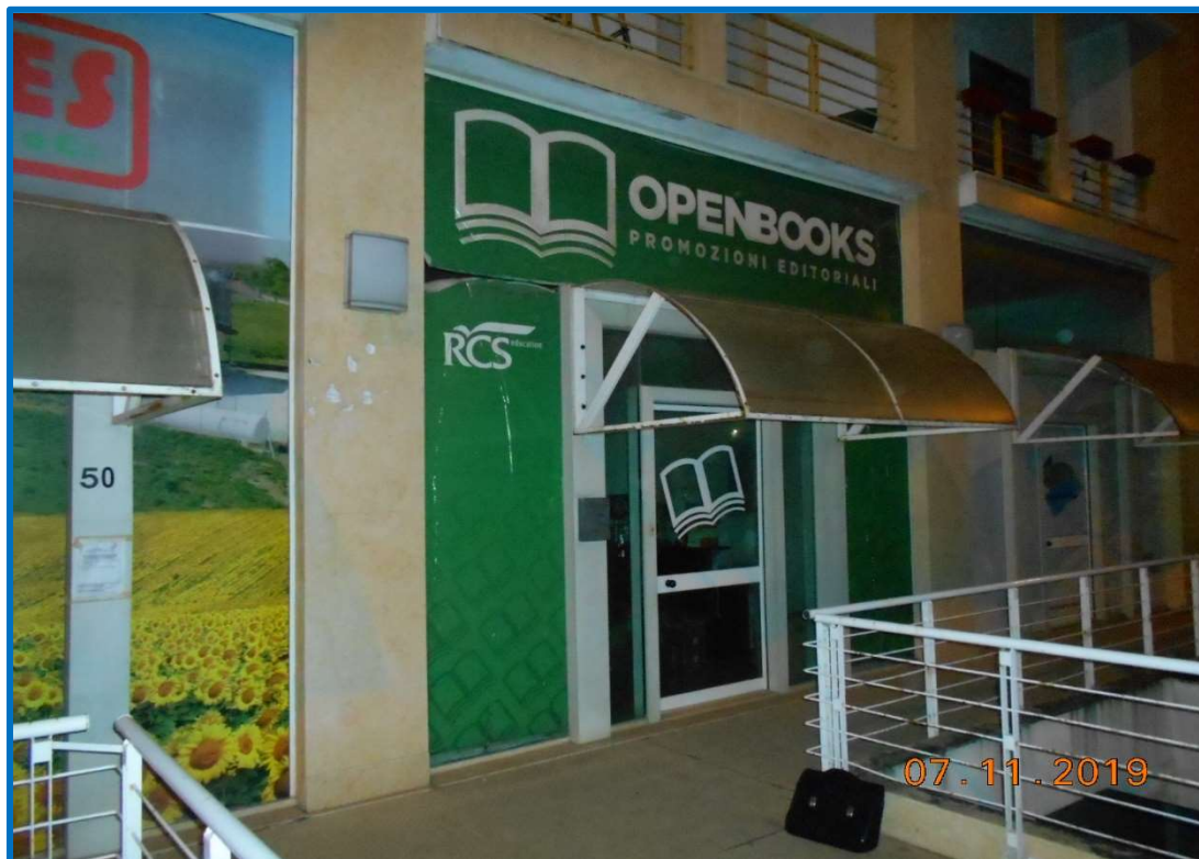
FOTO N.13: ingresso in piano terra all'immobile in sub 17 – lotto n.3
