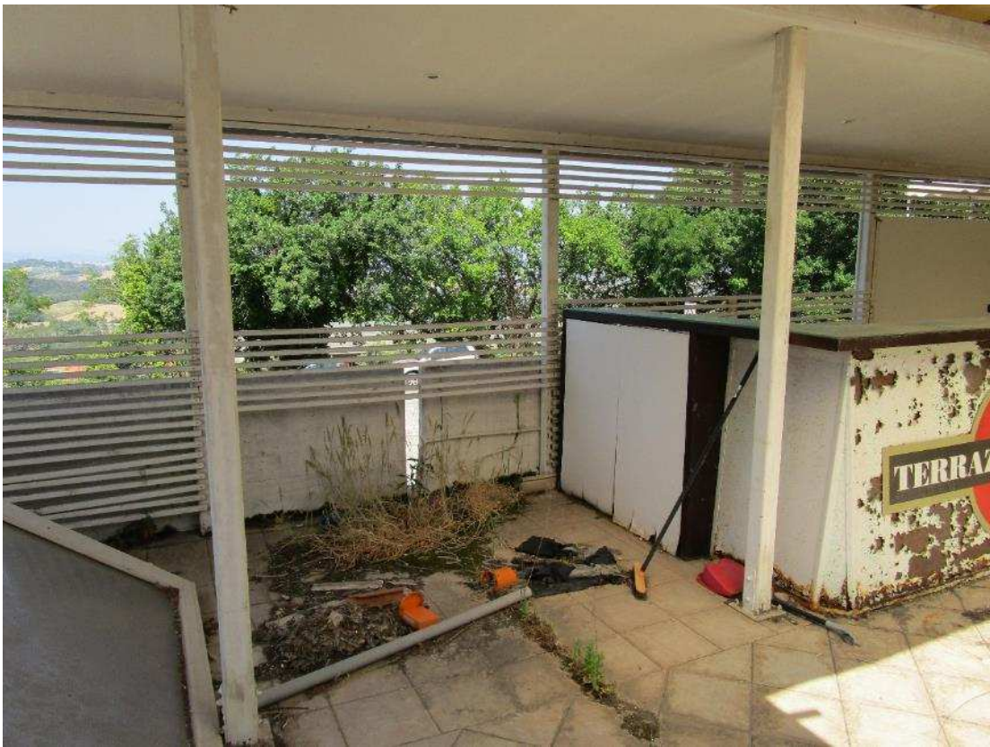
TERRAZZA PROSPICIENTE L'INGRESSO
