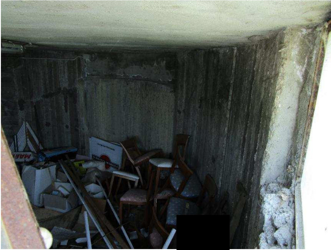
VISTA INTERNA MAGAZZINO
