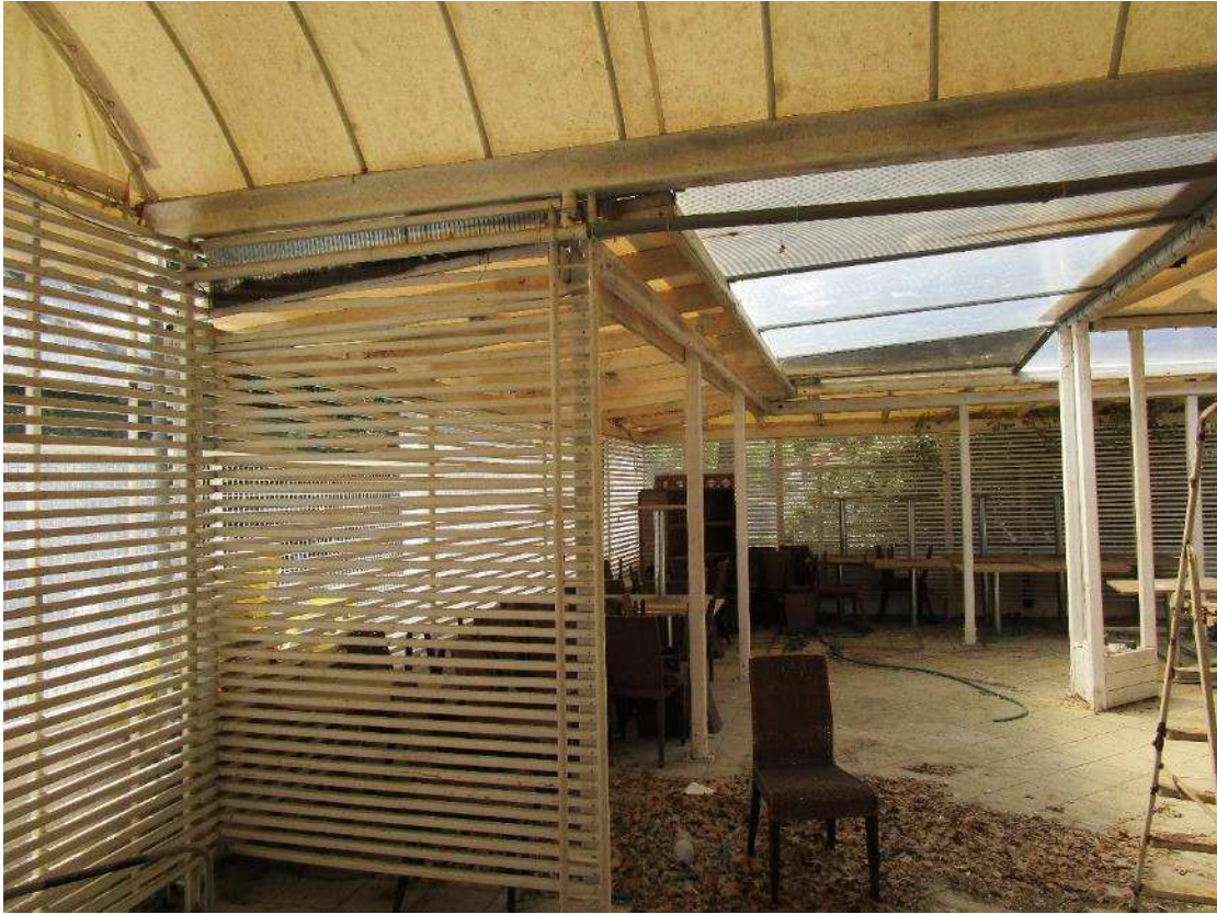
TERRAZZA PROSPICIENTE L'INGRESSO
