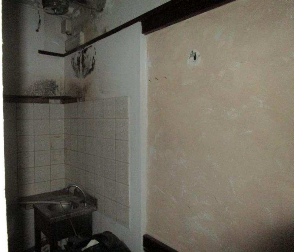
PARTICOLARE INFILTRAZIONI
