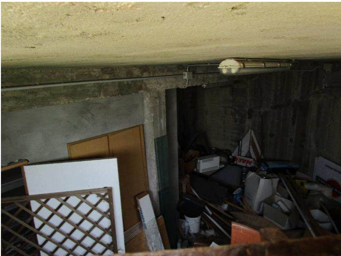
VISTA INTERNA MAGAZZINO
