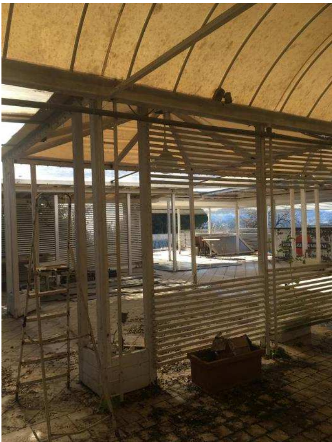
TERRAZZA PROSPICIENTE L'INGRESSO
