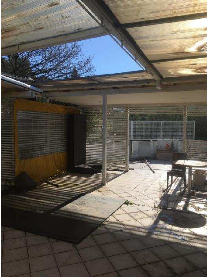
TERRAZZA PROSPICIENTE L'INGRESSO
