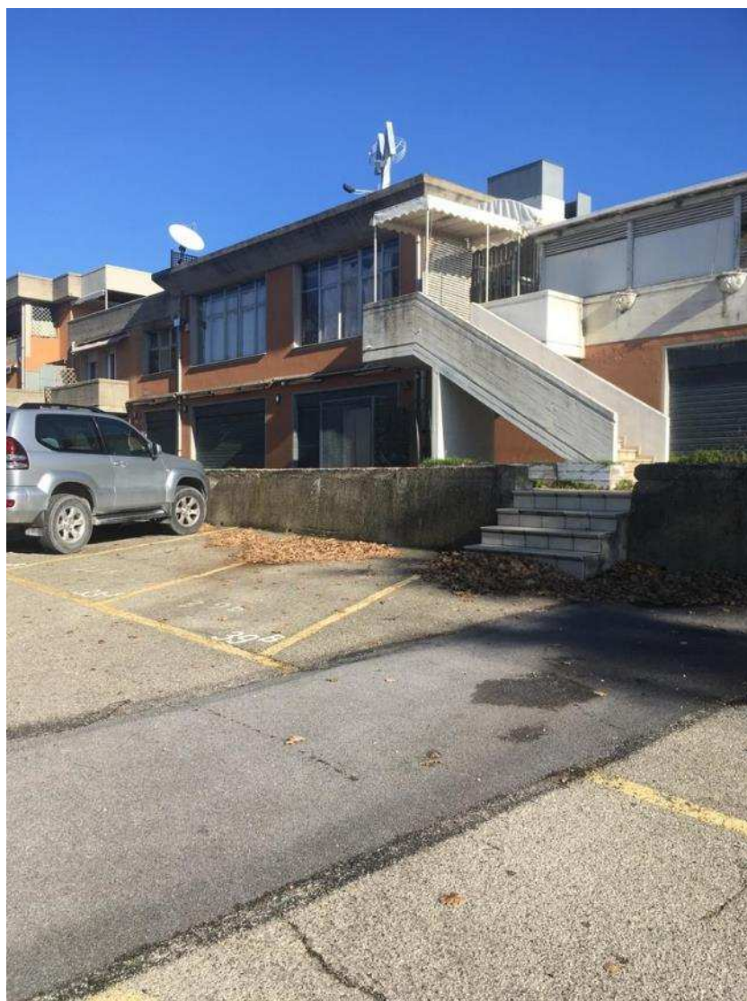
PARTICOLARE POSTO AUTO SCOPERTO
