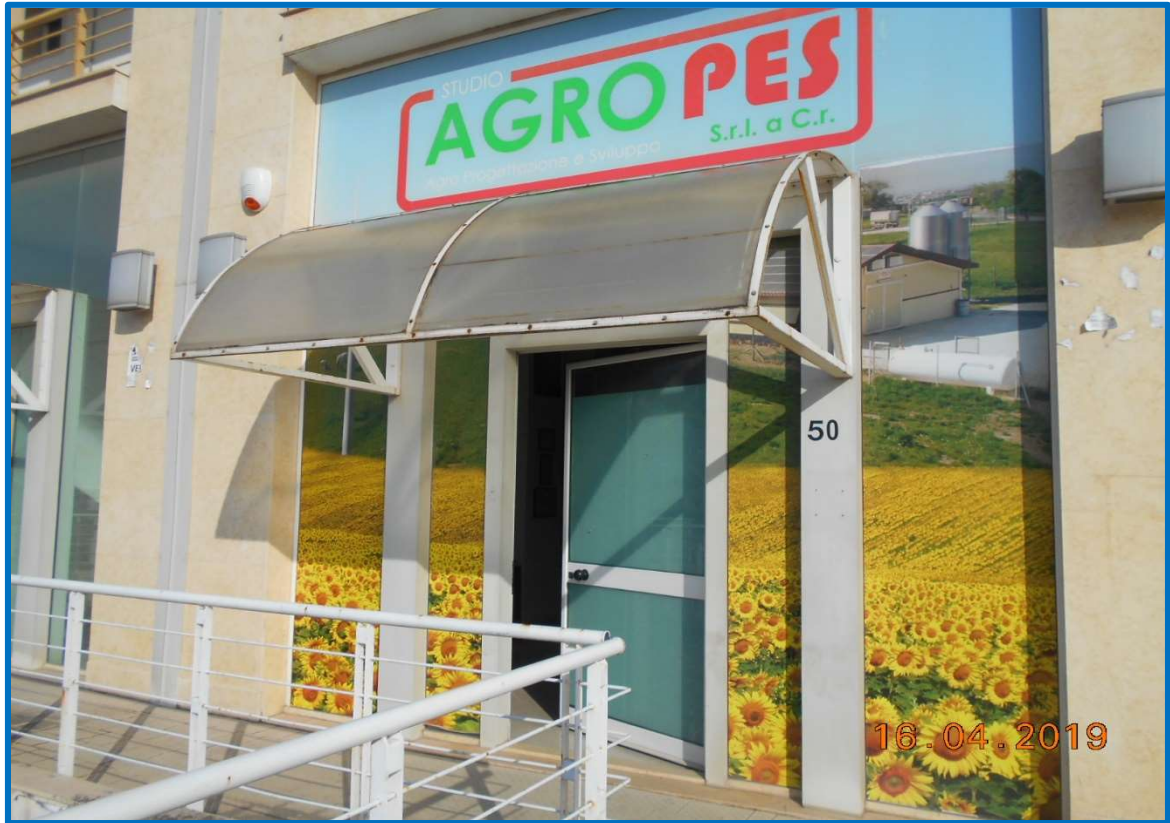
FOTO N.9: ingresso in piano terra all'immobile in sub 16 – lotto n.2
