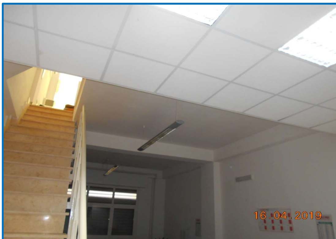
FOTO N.12: interno piano interrato dell'immobile in sub 16 – lotto n.2
