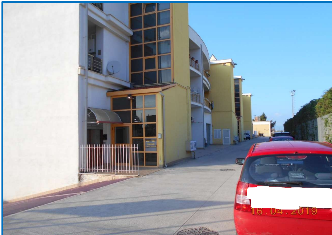
FOTO N.3: vista del fronte posteriore del fabbricato di via Manfredonia.
