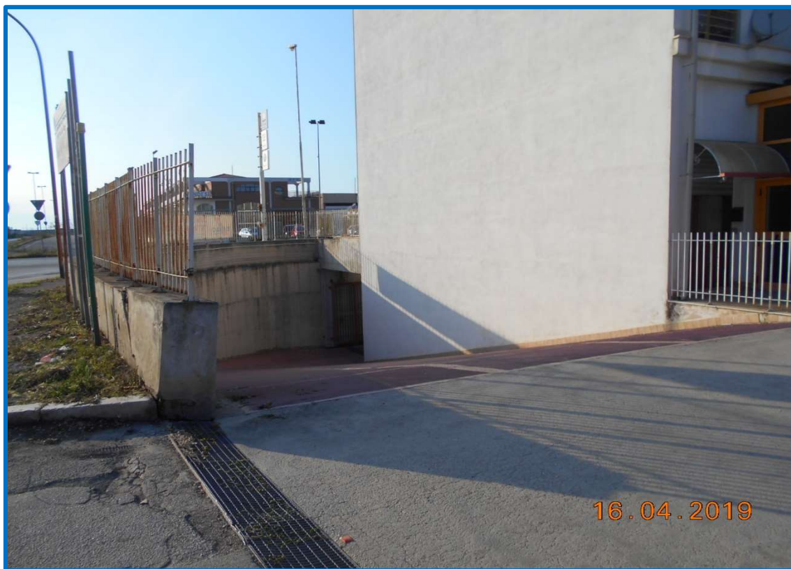
FOTO N.4: particolare della rampa di accesso al piano interrato su via delle Casermette.
