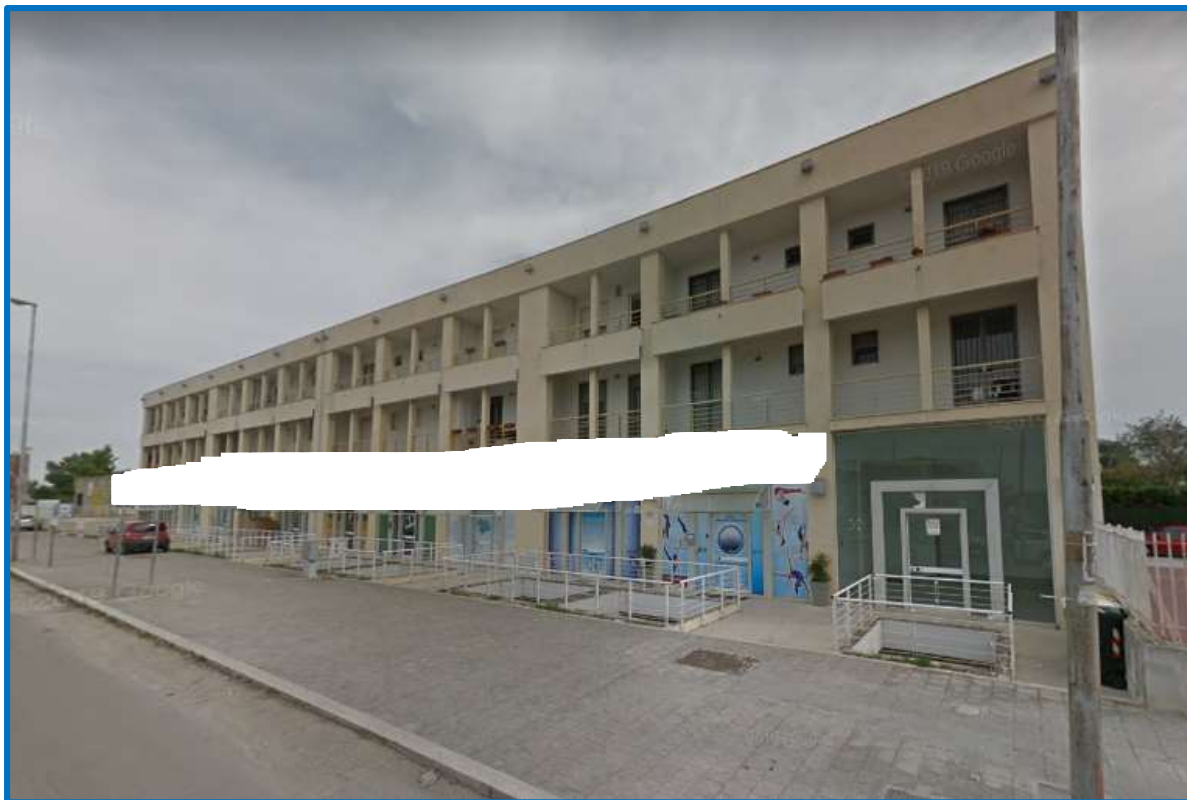
FOTO N.2: vista del fronte anteriore del fabbricato di via Manfredonia (fonte Google maps).
