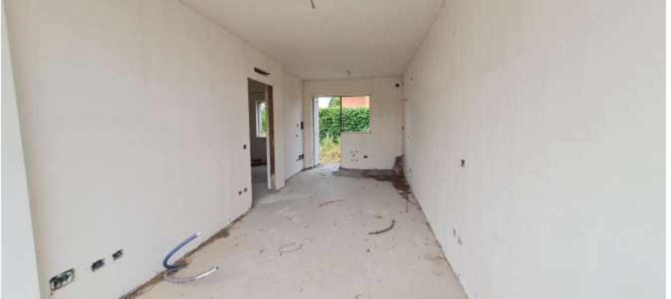
FOTO 15 – Vista dell'unità immobiliare sub 501-502-503
