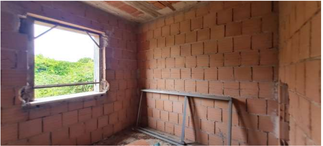
FOTO 23 – Vista dell'unità immobiliare sub 504-505-506
