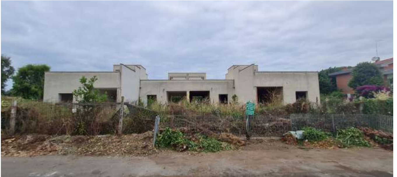
FOTO 1 – Vista del prospetto anteriore del fabbricato quadrifamiliare e della corte non divisa
