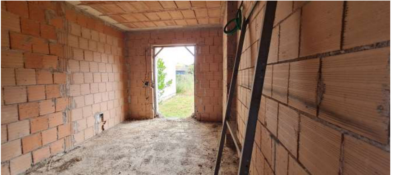
FOTO 21 – Vista dell'unità immobiliare sub 504-505-506
