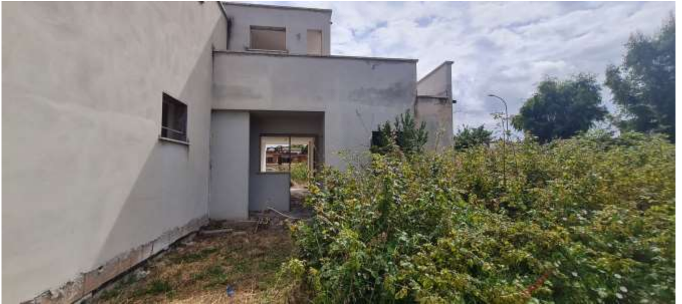
FOTO 5 – Vista dell'unità immobiliare sub 1-2
