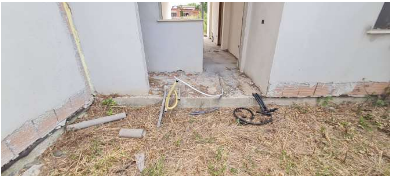
FOTO 6 – Vista dell'unità immobiliare sub 1-2
