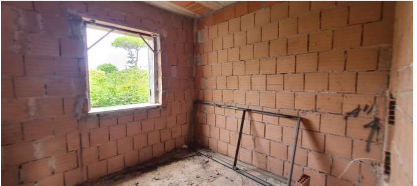
FOTO 29 – Vista dell'unità immobiliare sub 507-508-509
