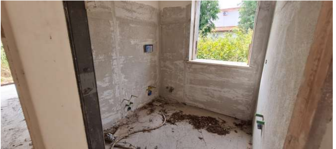
FOTO 11 – Vista dell'unità immobiliare sub 1-2
