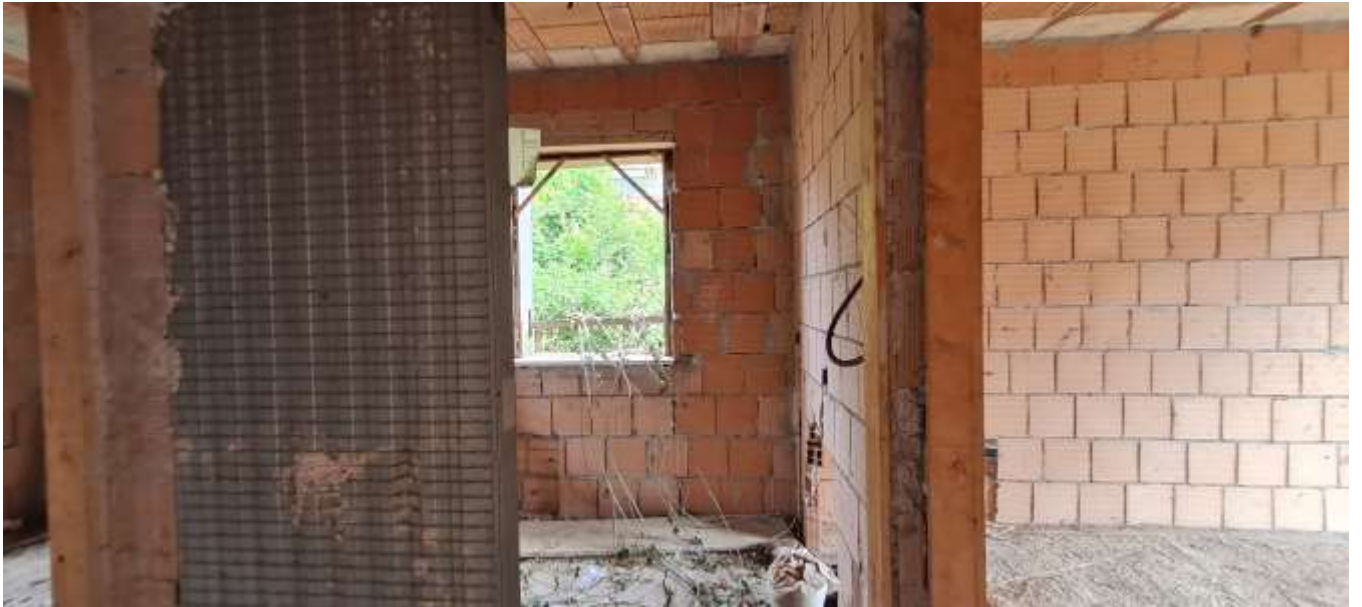
FOTO 27 – Vista dell'unità immobiliare sub 507-508-509
