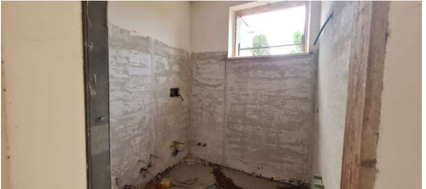
FOTO 17 – Vista dell'unità immobiliare sub 501-502-503
