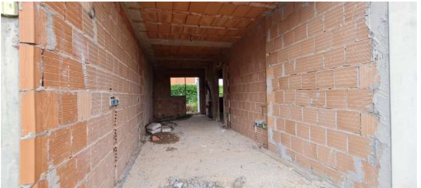
FOTO 19 – Vista dell'unità immobiliare sub 504-505-506
