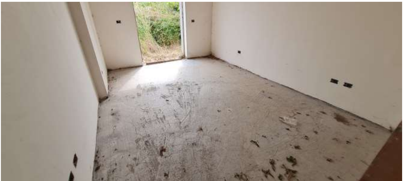
FOTO 10 – Vista dell'unità immobiliare sub 1-2
