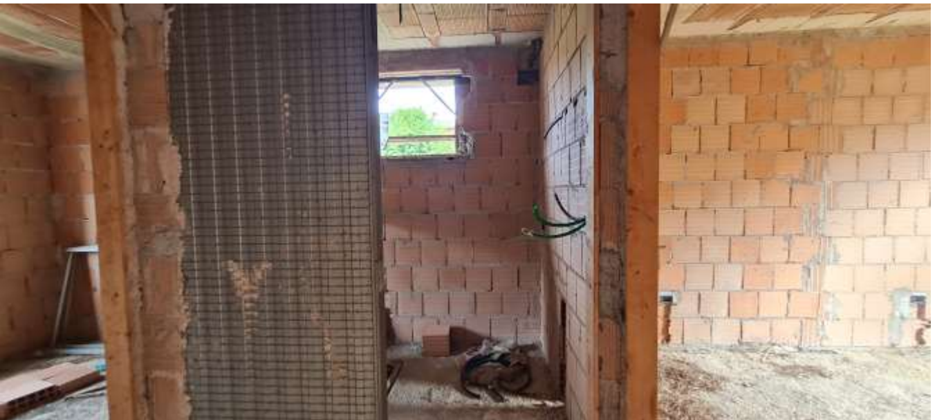
FOTO 24 – Vista dell'unità immobiliare sub 504-505-506
