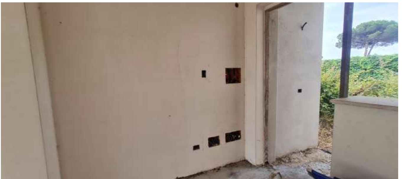
FOTO 8 – Vista dell'unità immobiliare sub 1-2
