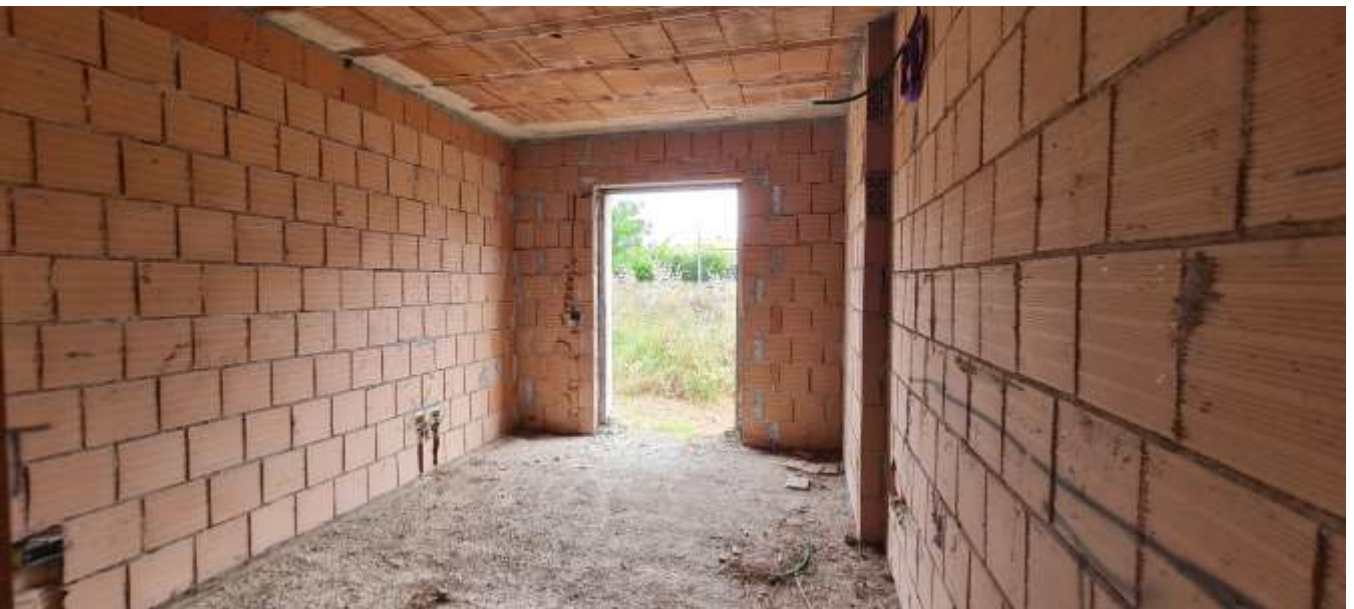
FOTO 26 – Vista dell'unità immobiliare sub 507-508-509
