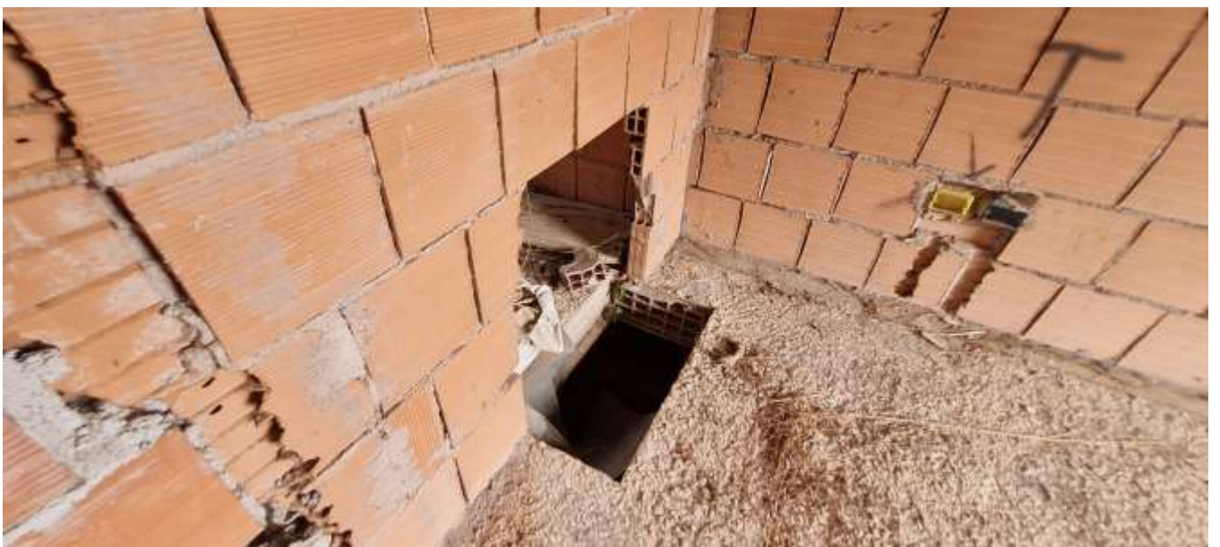
FOTO 28 – Vista dell'unità immobiliare sub 507-508-509
