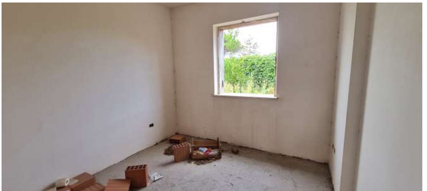
FOTO 18 – Vista dell'unità immobiliare sub 501-502-503
