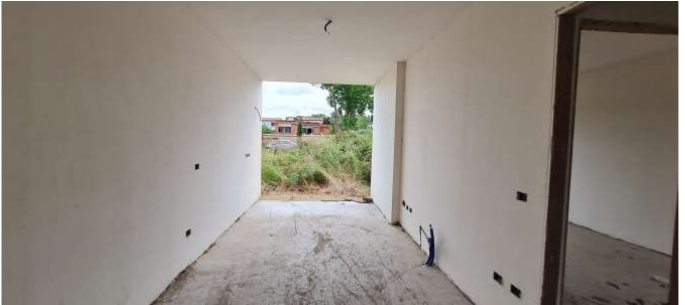
FOTO 13 – Vista dell'unità immobiliare sub 501-502-503
