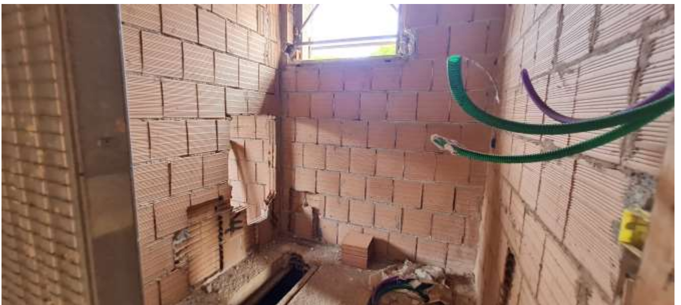
FOTO 22 – Vista dell'unità immobiliare sub 504-505-506
