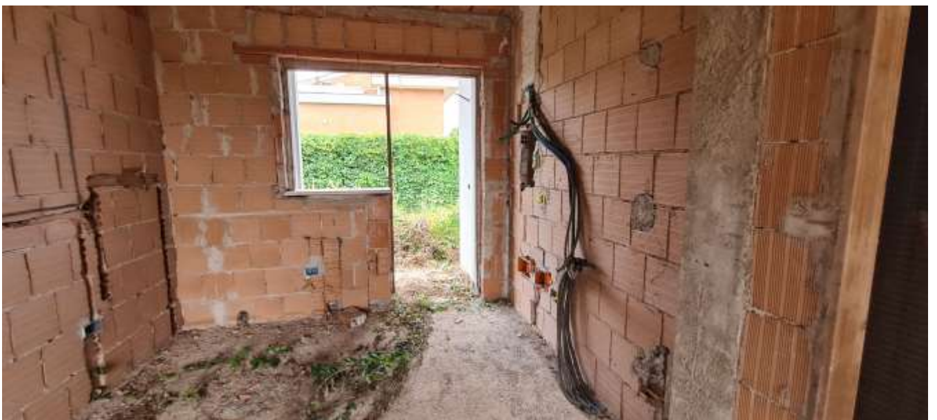
FOTO 20 – Vista dell'unità immobiliare sub 504-505-506
