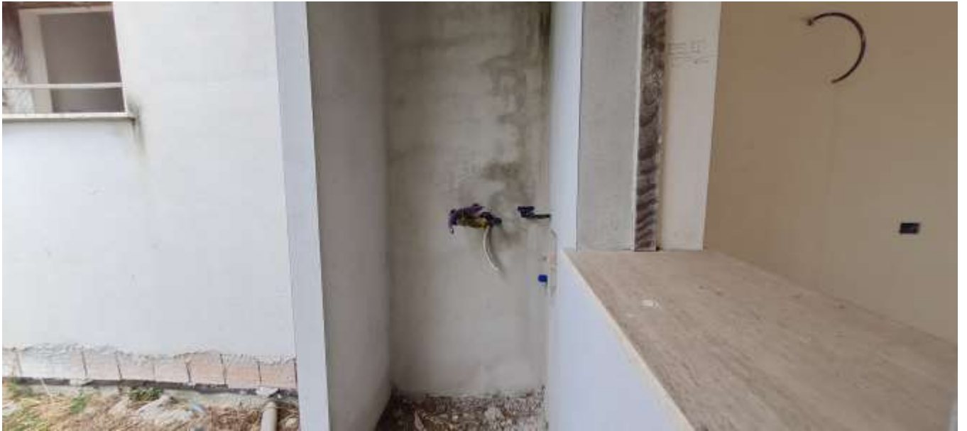
FOTO 7 – Vista dell'unità immobiliare sub 1-2
