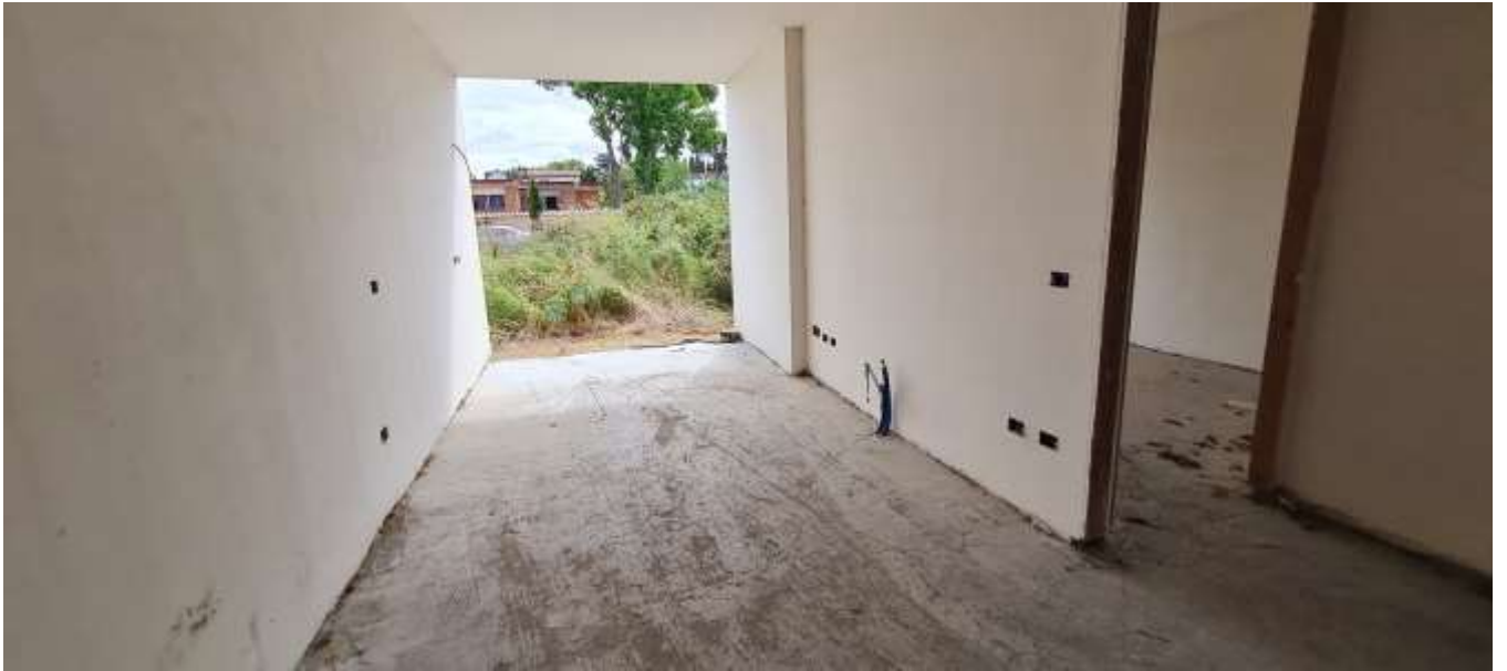
FOTO 9 – Vista dell'unità immobiliare sub 1-2
