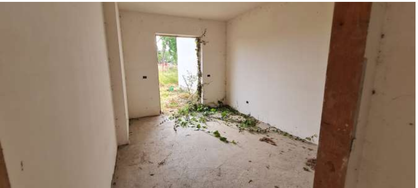
FOTO 16 – Vista dell'unità immobiliare sub 501-502-503
