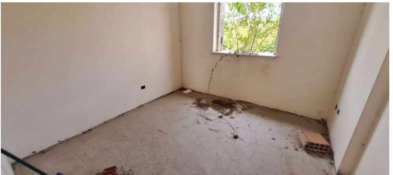
FOTO 12 – Vista dell'unità immobiliare sub 1-2
