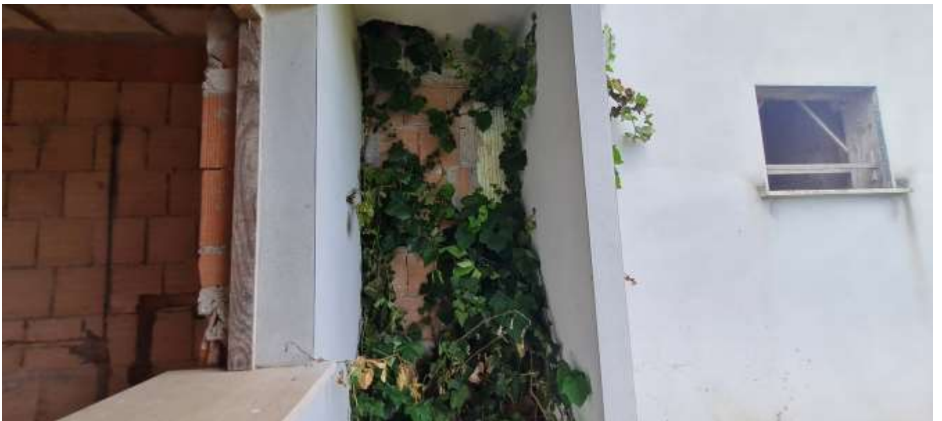
FOTO 30 – Vista dell'unità immobiliare sub 507-508-509
