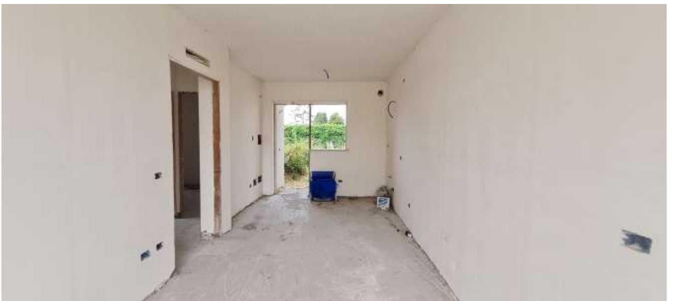
FOTO 14 – Vista dell'unità immobiliare sub 501-502-503
