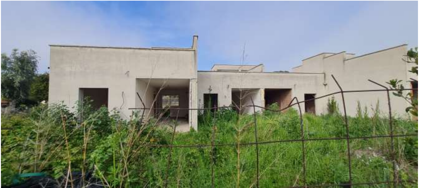
FOTO 3 – Vista delle 2 unità immobiliari a sinistra, sub 1-2 e 501-502-503, con lavorazioni più avanzate
