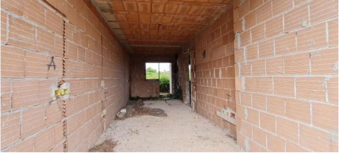
FOTO 25 – Vista dell'unità immobiliare sub 507-508-509
